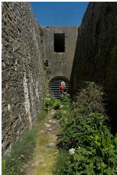
Vue de l'entrée en arc plein cintre du magasin à poudre sous roc de la batterie de mortier. Daté 1891, il a été aménagé dans le fossé de la batterie de mortier
