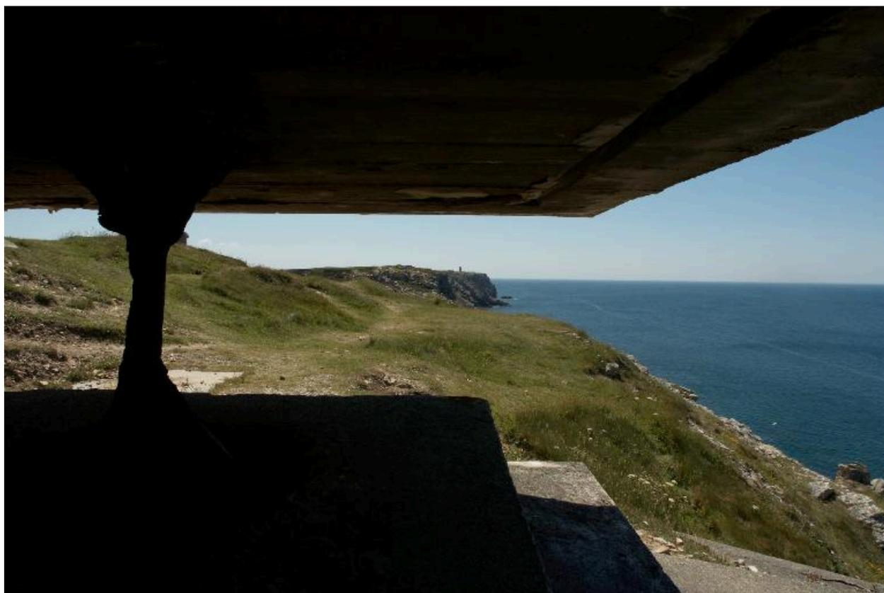
Vue du bunker - poste de direction de tir de type M162a : poteau métallique supportant la dalle de couverture de l'observatoire
