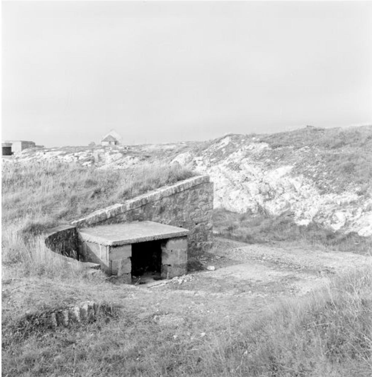
Vue de la batterie de mortier en 1969 : l'une des trois plates-formes de tir à ciel ouvert avec un petit abri en parpaing de béton couvert d'une dalle en béton de faible épaisseur
