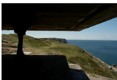
Vue du bunker - poste de direction de tir de type M162a : poteau métallique supportant la dalle de couverture
