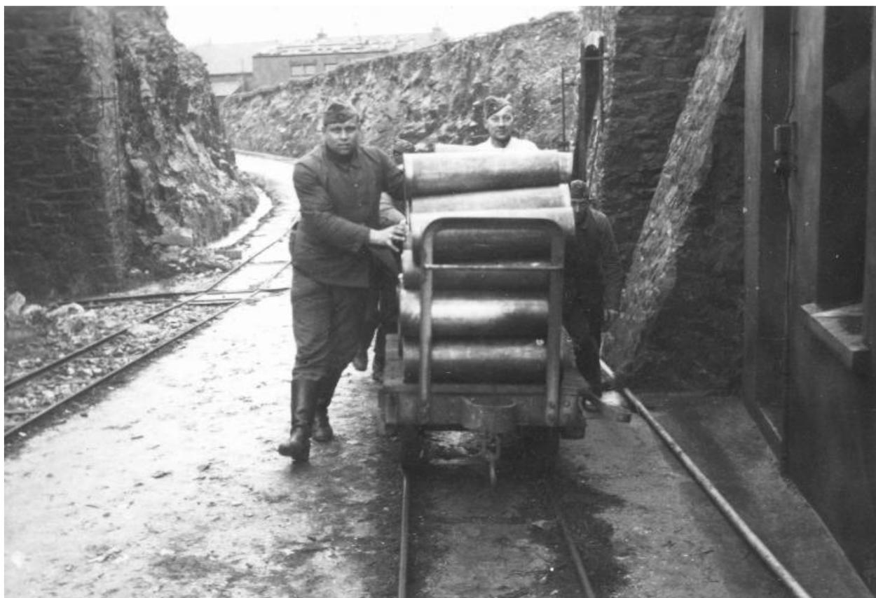
Vue du transport des munitions par wagonnets sur voies étroites de 60 cm d'écartement (ici, des gargousses) dans le fossé de la batterie de mortier. Les soldats regardent l'objectif. En arrière-plan, un casernement (?)
