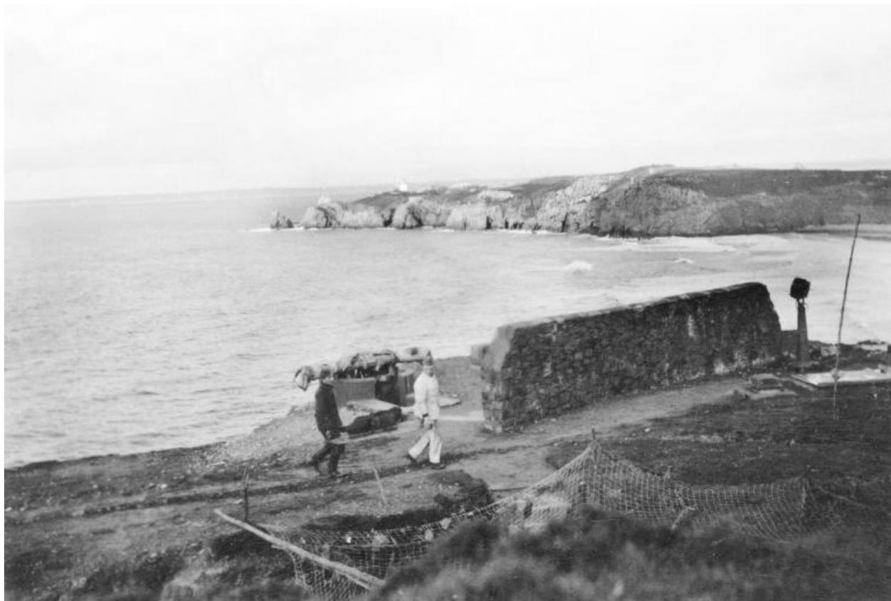
Vue du télémètre (la cuve existe toujours) à côté du poste de direction de tir français avant la construction du bunker - poste de direction de tir de type de type M162a. Deux soldats transportent des caisses de munitions (?) sur un brancart en bois. A droite, un projecteur. En arrière-plan, la pointe du Toulinguet
