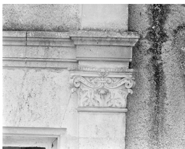
Elévation est : détail d'un chapiteau en terre cuite. Phot. Guy Artur, Phot. Norbert Lambart IVR53_19963500763X
