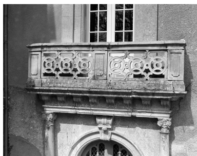
Elévation principale : détail du balcon. Phot. Guy Artur, Phot. Norbert Lambart IVR53_19963500803X
