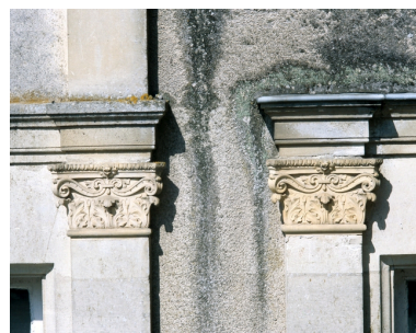
Elévation est : détail d'un chapiteau en terre cuite. Phot. Guy Artur, Phot. Norbert Lambart IVR53_19973500708XA
