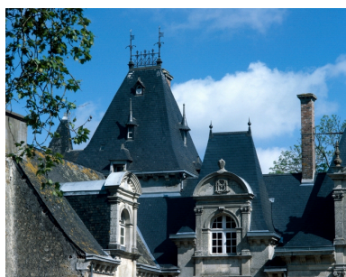
Vue générale des fenêtres sous toiture. Phot. Guy Artur, Phot. Norbert Lambart IVR53_19973500710XA
