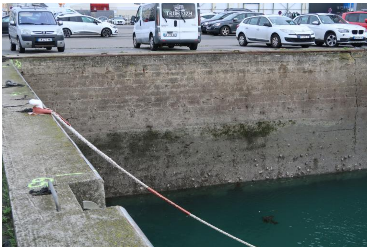
2e bassin, quai du 2e éperon
