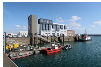
Bassin 2, quai est, ponton, vue du 2e éperon Phot. Erwana L'Haridon IVR53_20212905644NUCA
