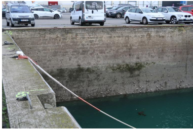
2e bassin, quai du 2e éperon Phot. Erwana L'Haridon IVR53_20202905248NUCA
