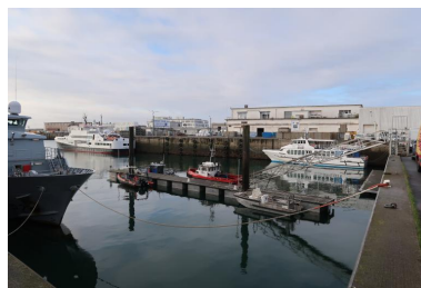
2e bassin : Douanes ; desserte des îles ; pompier maritime ; Région Bretagne (antenne portuaire de Brest) Phot. Erwana L'Haridon IVR53_20202905240NUCA
