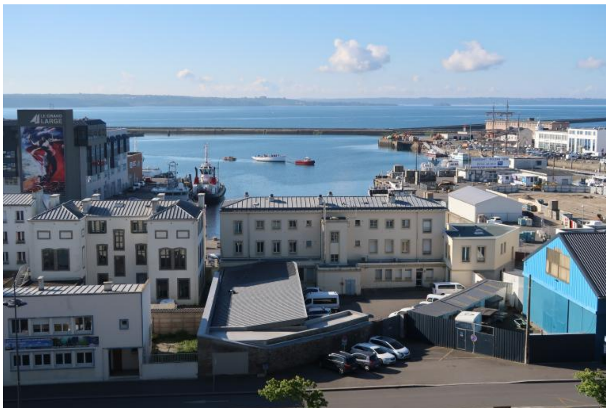
2e bassin, digue sud, immeubles de logement, de bureaux et de commerce
