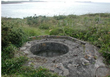
Vue générale (état en 2002). En arrière-plan, le Fort Cézon et l'embouchure de l'Aber Wrac'h Phot. Guillaume Lécueillier IVR53_20032902361NUCA
