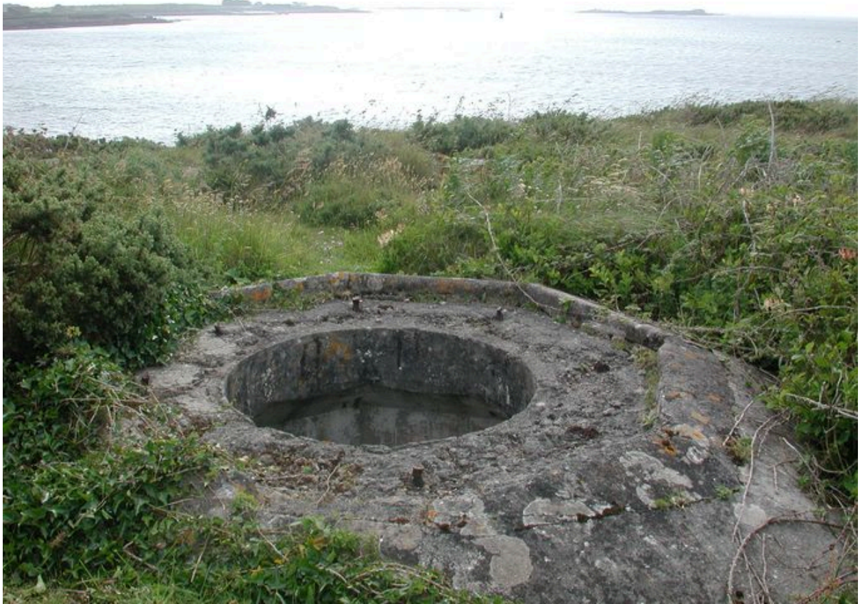
Vue générale (état en 2002). En arrière-plan, le Fort Cézon et l'embouchure de l'Aber Wrac'h
