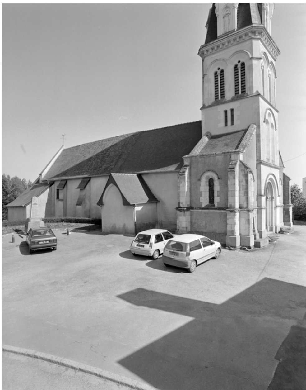
Elévation Nord-Ouest : vue générale
