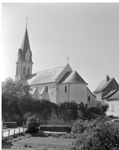
Elévation Sud-Est : vue générale Phot. Guy Artur, Phot. Norbert Lambart IVR53_19943500945X
