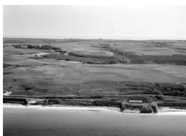
Vue aérienne prise du nord-est, partie centrale
