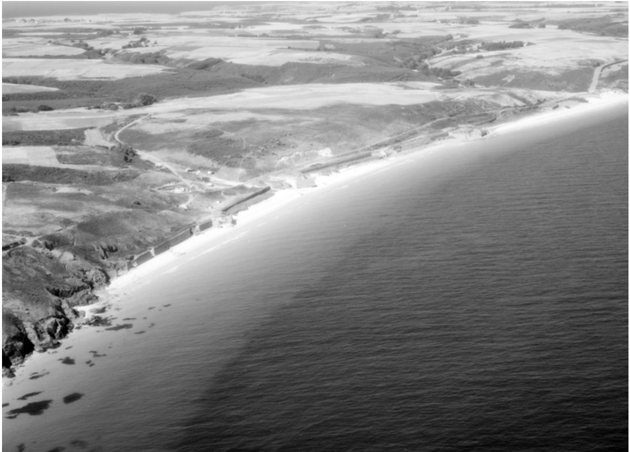
Vue aérienne prise de l'est
