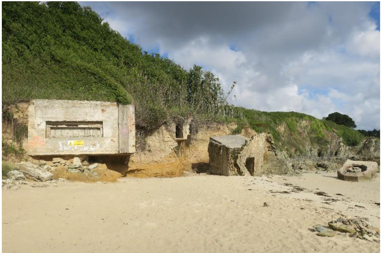
Locmaria, Grands Sables, extrémité ouest effondrée.
