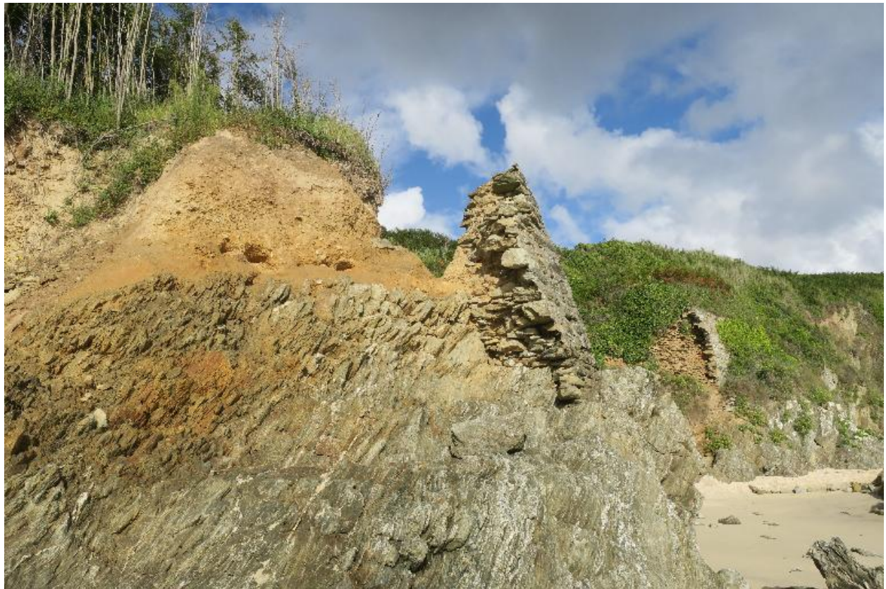
Locmaria, Grands Sables, extrémité ouest effondrée.
