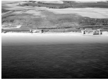
Vue aérienne prise du nord-est, partie centrale Phot. G.A.L.R.E.G. IVR53_19755600340V
