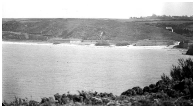
Vue de situation de la porte de Bugull Phot. Jean-Pierre Ducouret IVR53_19745600800Z
