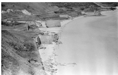
Vue générale prise du sud-est Phot. Jean-Pierre Ducouret IVR53_19745600825Z
