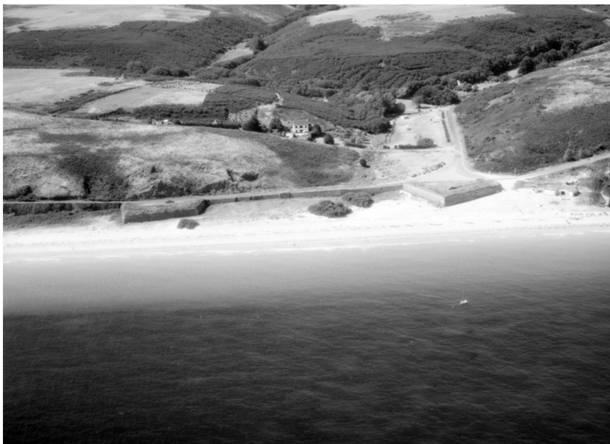
Vue aérienne prise du nord-est, partie ouest
