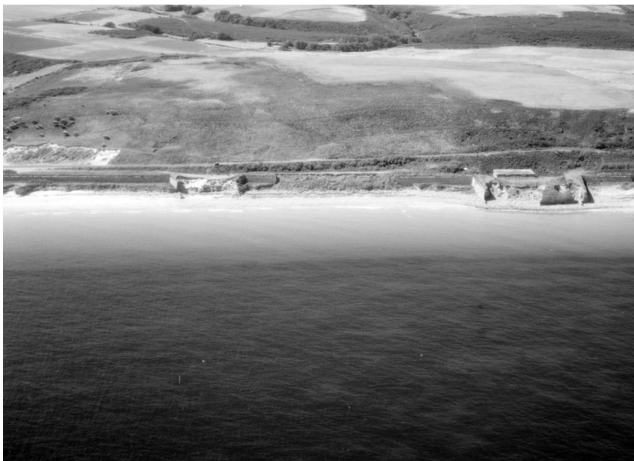
Vue aérienne prise du nord-est, partie centrale
