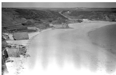
Vue générale prise du sud-est Phot. Jean-Pierre Ducouret IVR53_19745600826Z
