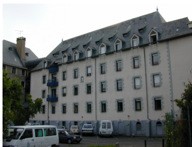
Bâtiment construit au sud au 19e siècle, vue ouest Phot. Isabelle Barbedor IVR53_20003517881NUCA
