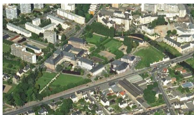
Vue aérienne Phot. R. Busch IVR53_20003517827NUCA
