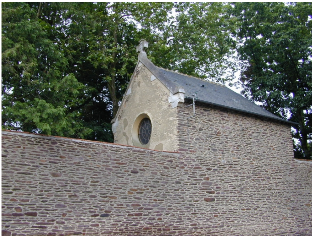
Chapelle du Coeur de Jésus, vue nord
