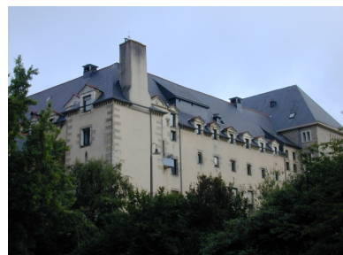
Bâtiments conventuels vus du sud Phot. Isabelle Barbedor IVR53_20003517876NUCA
