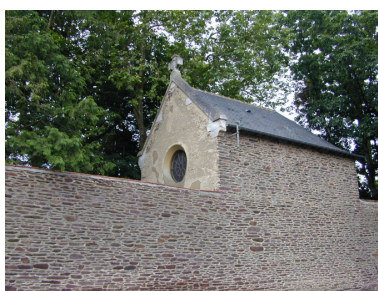
Chapelle du Coeur de Jésus, vue nord Phot. Isabelle Barbedor IVR53_20003517883NUCA
