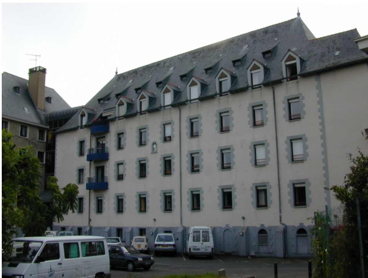
Bâtiment construit au sud au 19e siècle, vue ouest
