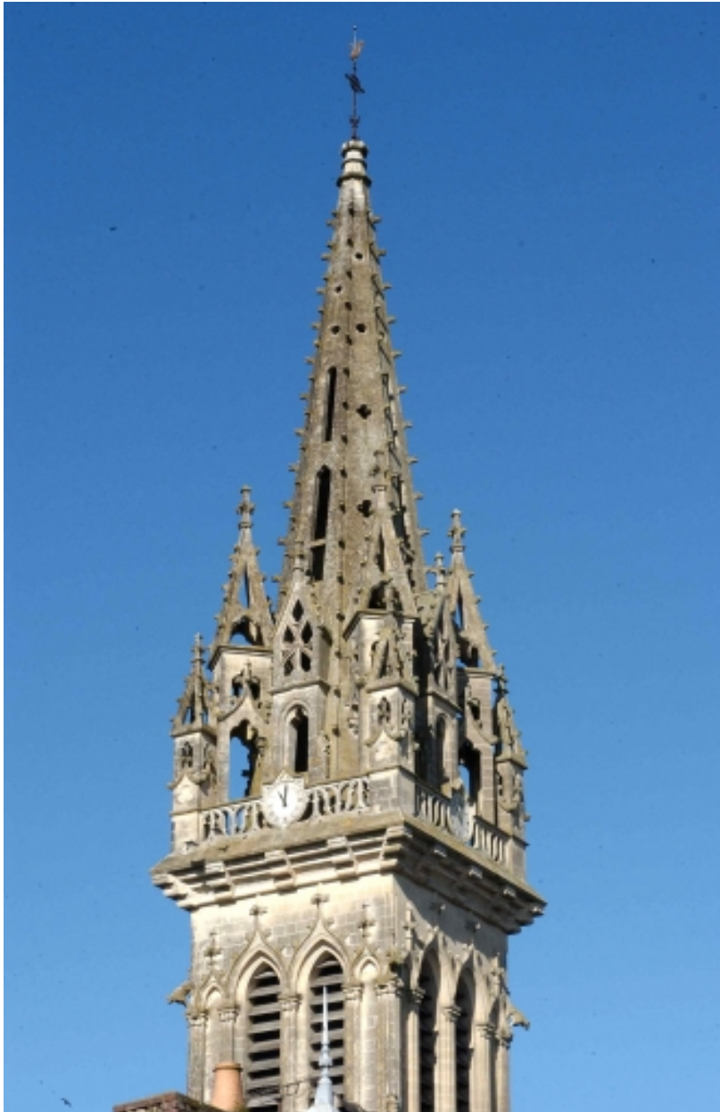
Le clocher : vue générale sud-est
