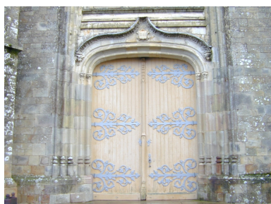
Façade ouest, portail Phot. Xavier Gilbert IVR53_20033509929NUCA
