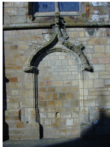
Façade sud, détail, ancienne porte des prêtres, murée Phot. Xavier Gilbert IVR53_20033509923NUCA
