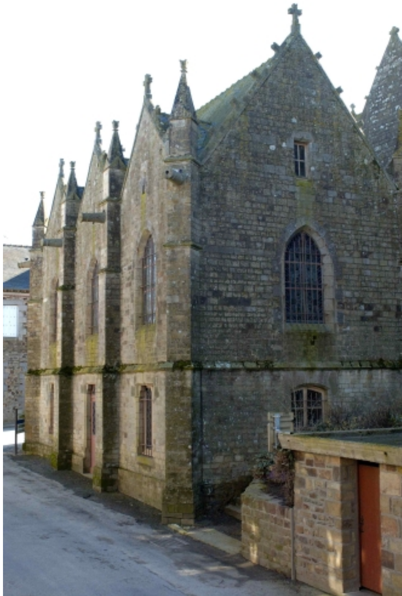
Façade nord, la sacristie construite à la fin du 19e siècle
