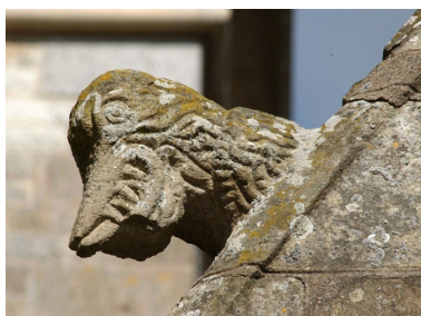
Façade ouest, détail d'une sculpture du rampant du pignon Phot. Guy Artur, Phot. Norbert Lambart IVR53_20033517893NUCA
