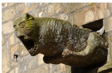
Façade sud, détail, gargouille d'un contrefort Phot. Guy Artur, Phot. Norbert Lambart IVR53_20033517889NUCA
