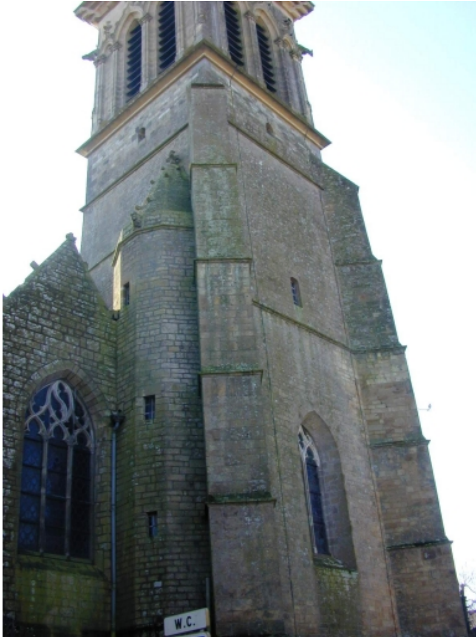
La tour bâtie en 1552 : vue générale nord-ouest
