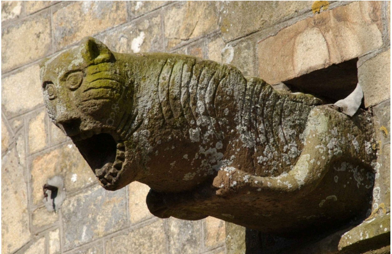
Façade sud, détail, gargouille d'un contrefort
