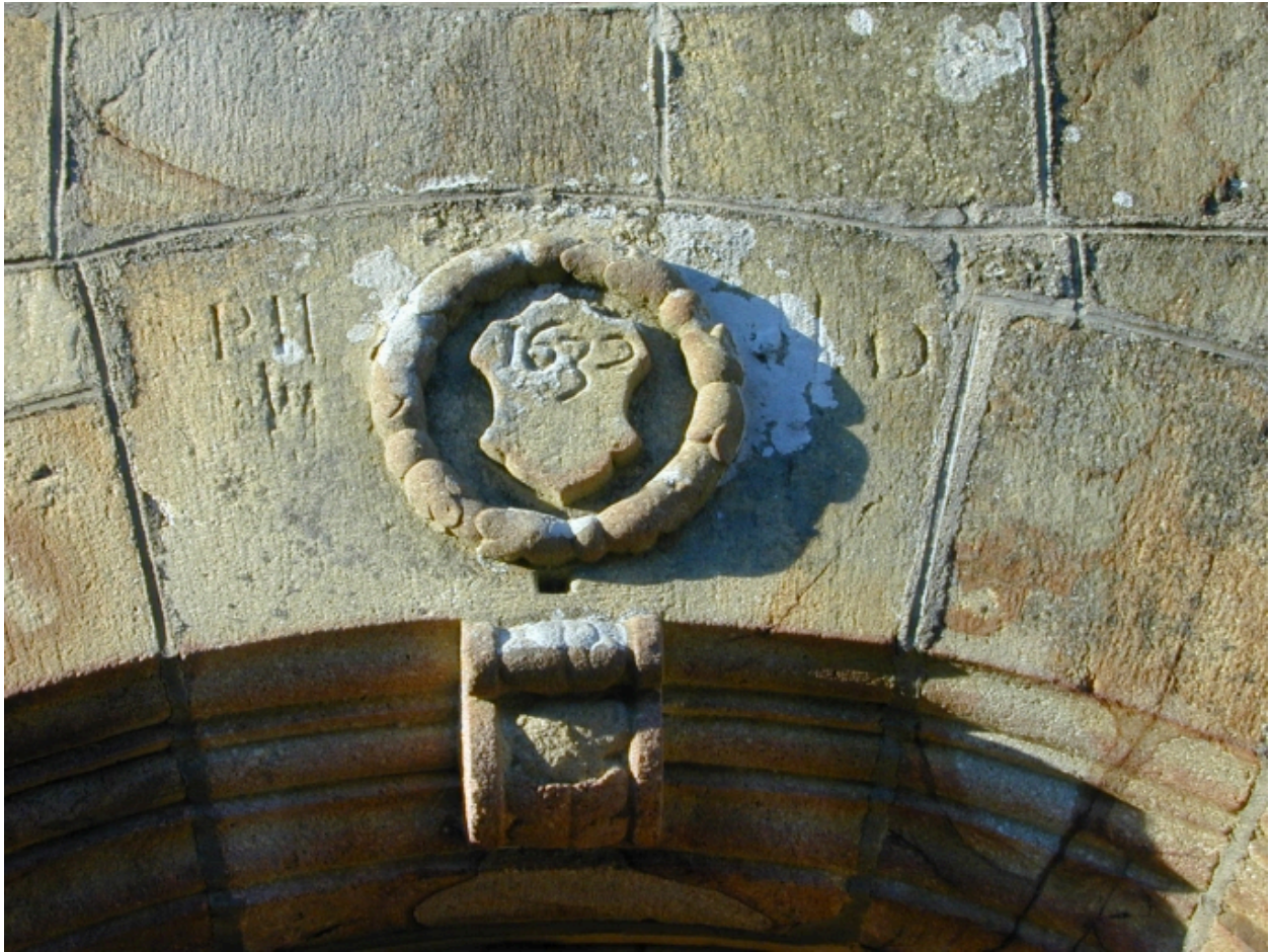
Façade sud, détail, porte de la nef, clef gravée de la date de 1632
