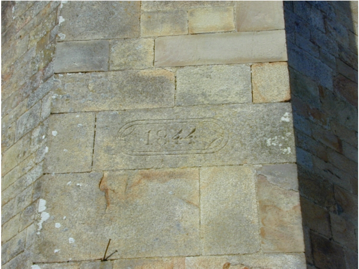
Façade ouest, détail, date de réfection de 1844, gravée sur le contrefort d'angle
