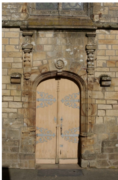
Façade sud, détail, porte des fidèles Phot. Guy Artur, Phot. Norbert Lambart IVR53_20033517887NUCA
