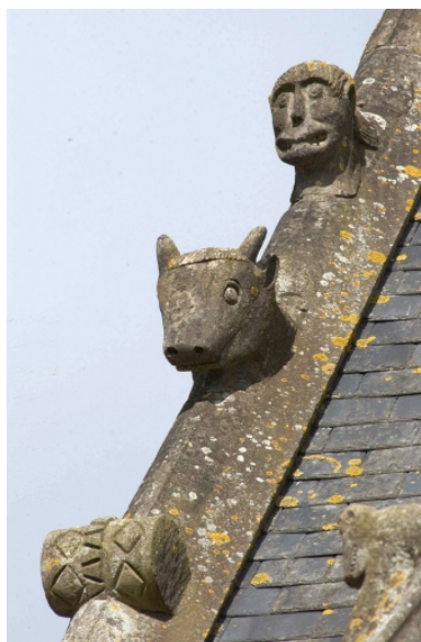
Façade ouest, détail du pignon, sculptures du rampant Phot. Guy Artur, Phot. Norbert Lambart IVR53_20033517892NUCA
