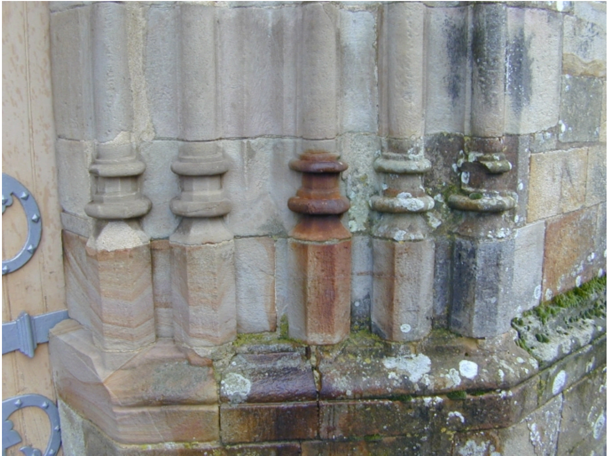
Façade ouest, portail, détail
