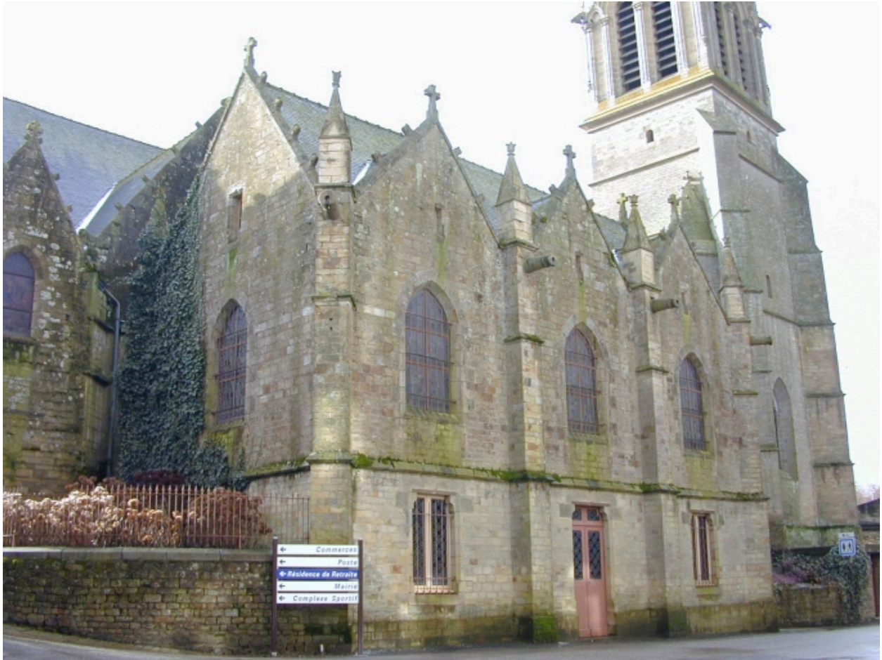
Façade nord, la sacristie
