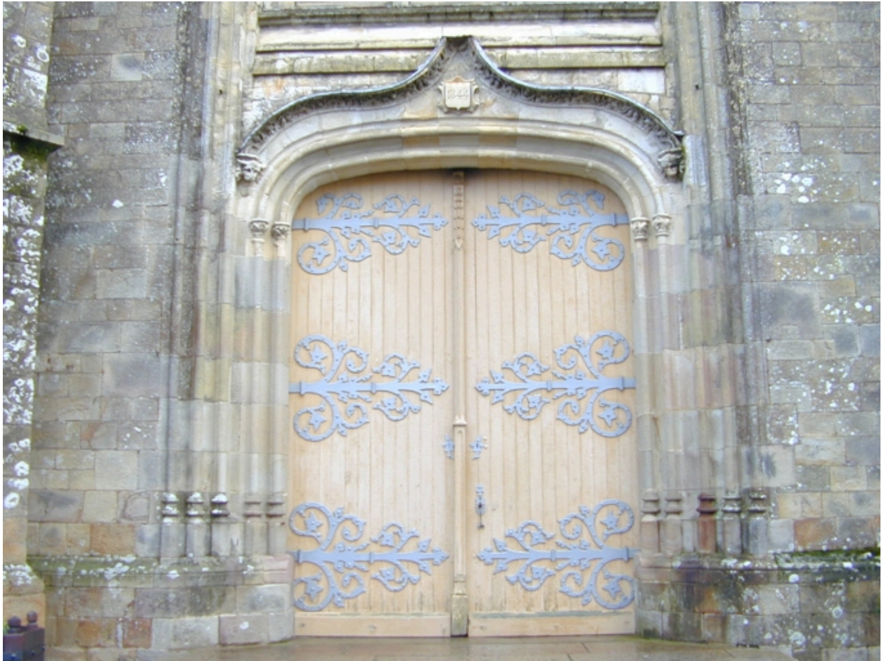
Façade ouest, portail
