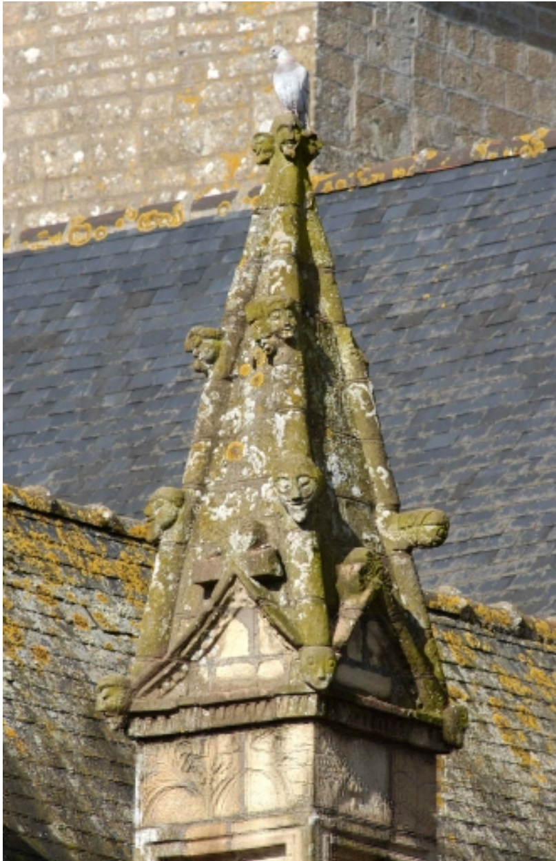
Façade sud, détail, pinacle d'un contrefort
