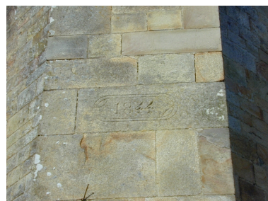
Façade ouest, détail, date de réfection de 1844, gravée sur le contrefort d'angle Phot. Xavier Gilbert IVR53_20033509928NUCA
