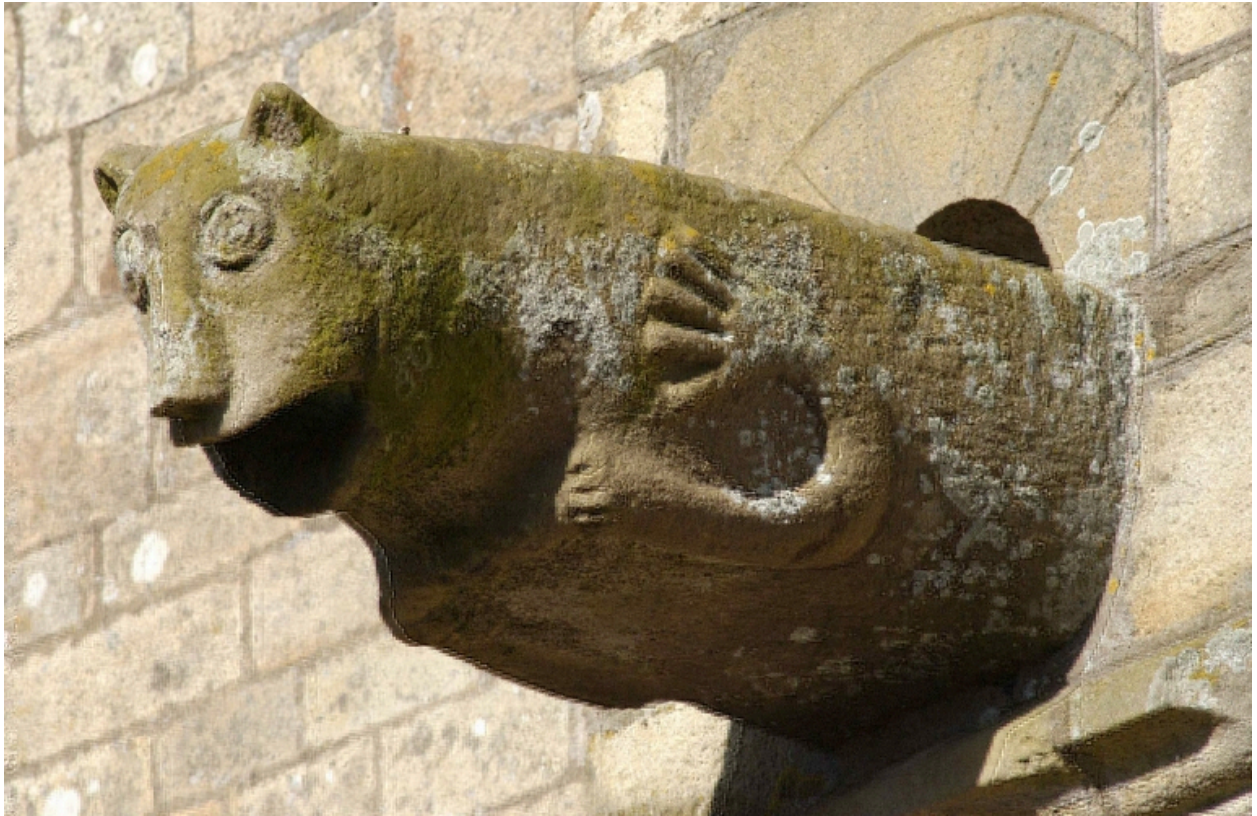
Façade sud, détail, gargouille d'un contrefort
