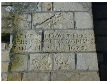
Façade sud, détail, contrefort avec inscription et date portée 1632 Phot. Xavier Gilbert IVR53_20033509927NUCA
