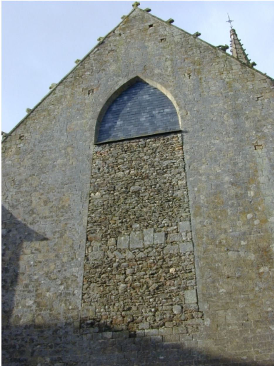
Façade est, le chevet avec baie murée
