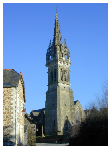
Le clocher vue depuis la route de Bais : vue de situation nord-ouest Phot. Xavier Gilbert IVR53_20033509917NUCA
