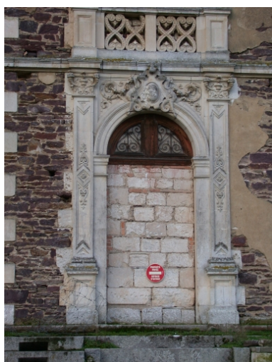
Porte, détail du décor Phot. Véronique Orain IVR53_20033515988NUCA
