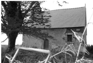
Vue générale prise de l'ouest Phot. Auteur inconnu IVR53_20125600311Z
