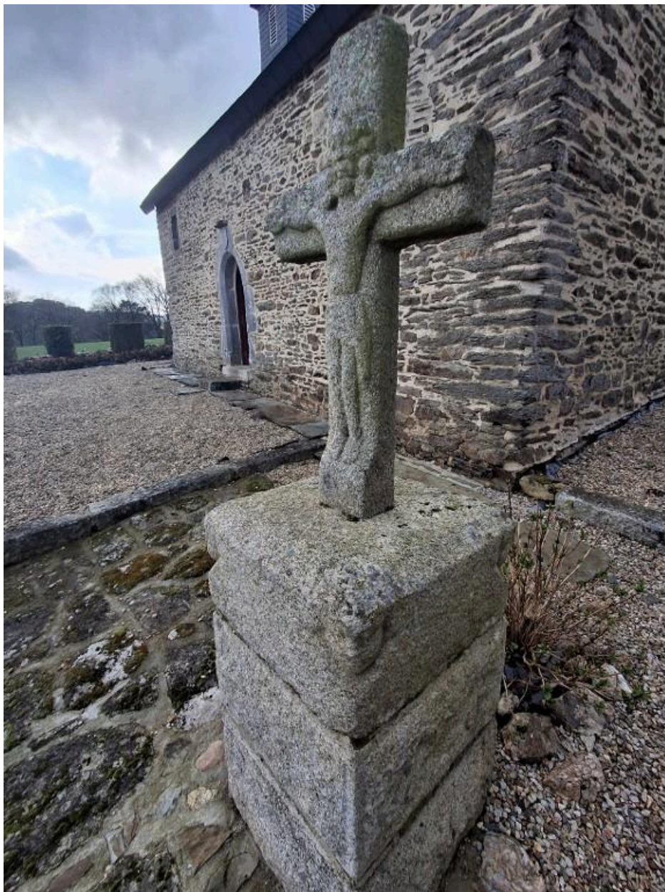
Vue sud-est de l'édifice.
