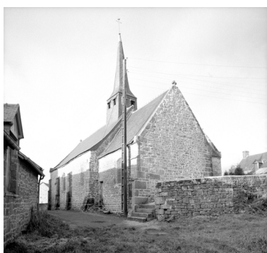
Elévation Sud-Est : vue générale Phot. Bernard Bègne, Phot. M. Loyon IVR53_19943500055X
