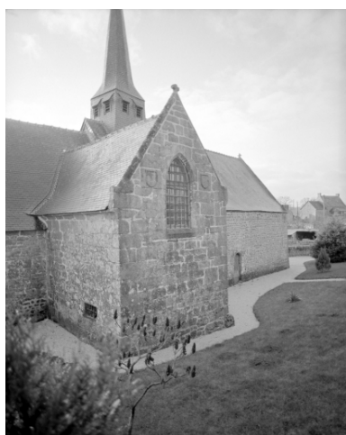
Elévation Nord-Est : vue générale Phot. Bernard Bègne, Phot. M. Loyon IVR53_19943500054X
