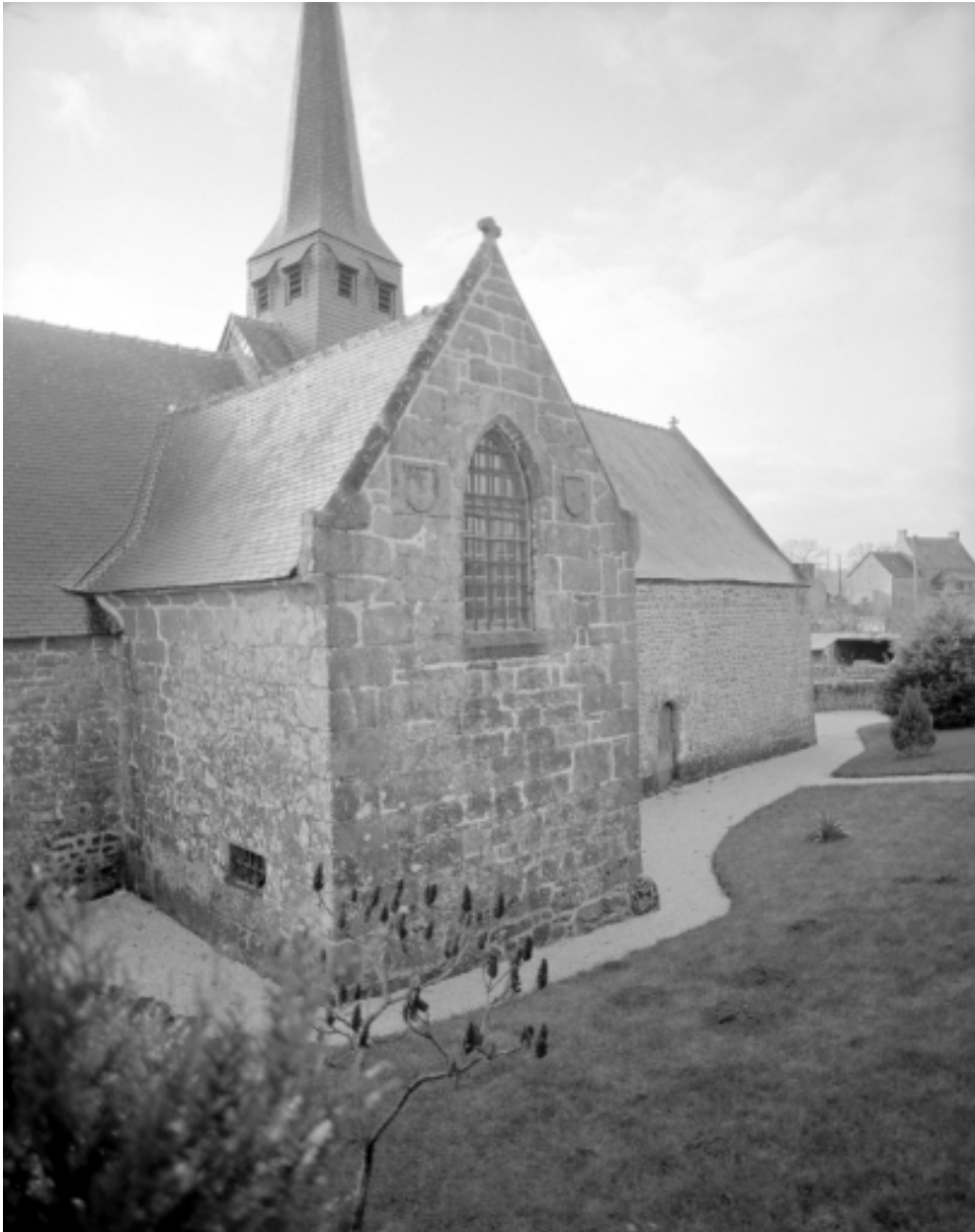
Elévation Nord-Est : vue générale
