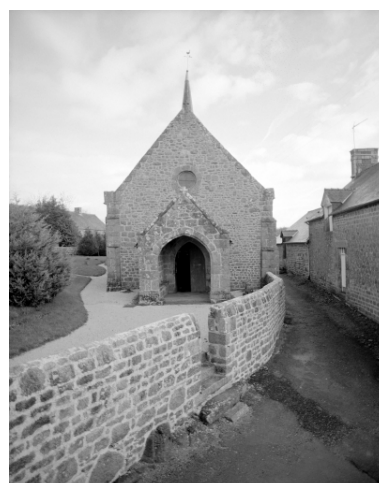
Elévation Ouest : vue générale Phot. Bernard Bègne, Phot. M. Loyon IVR53_19943500057X
