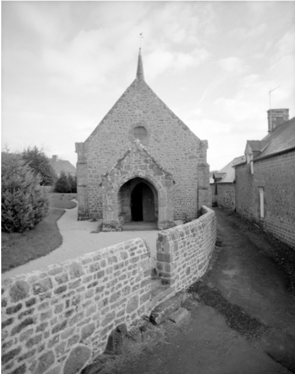
Elévation Ouest : vue générale
