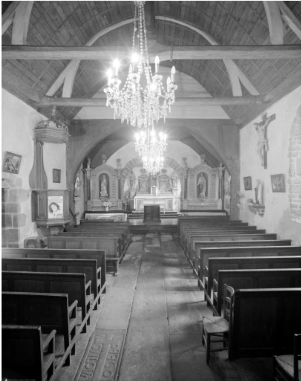
Intérieur : vue générale vers le chœur.
