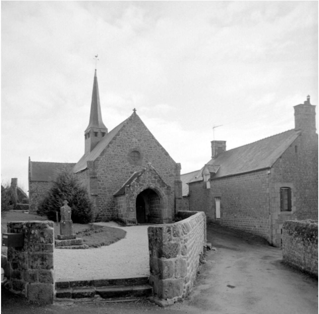
Elévation Nord-Ouest : vue générale
