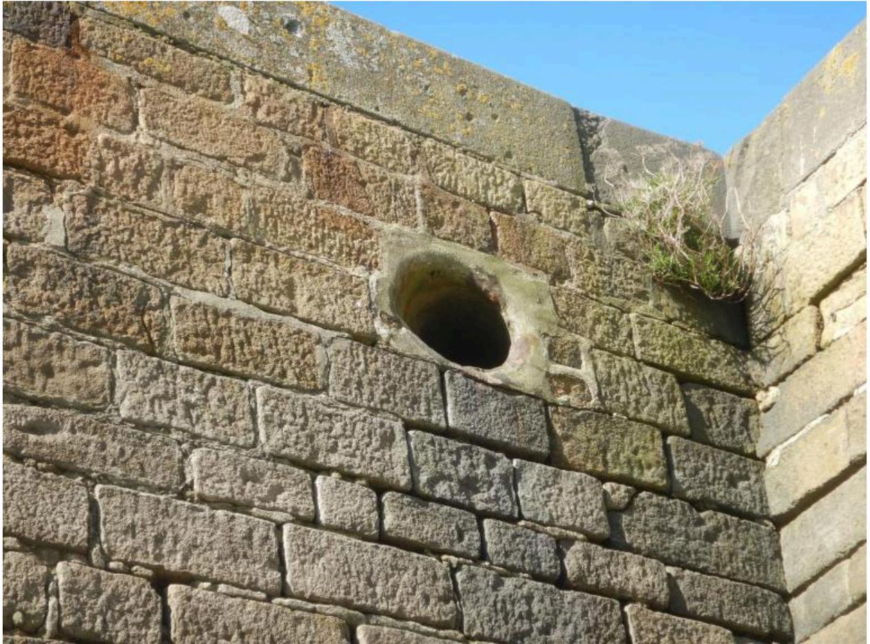
3e bassin, quai nord, dispositif de collecte et évacuation des eaux dans la maçonnerie
