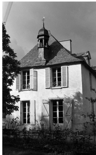
Façade sud : vue générale en 1974 Phot. C. Laisis IVR53_19743505329Z
