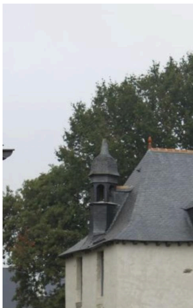
Façade sud : détail du clocheton Phot. Déborah De Sousa Figueiredo IVR53_20163505769NUCA
