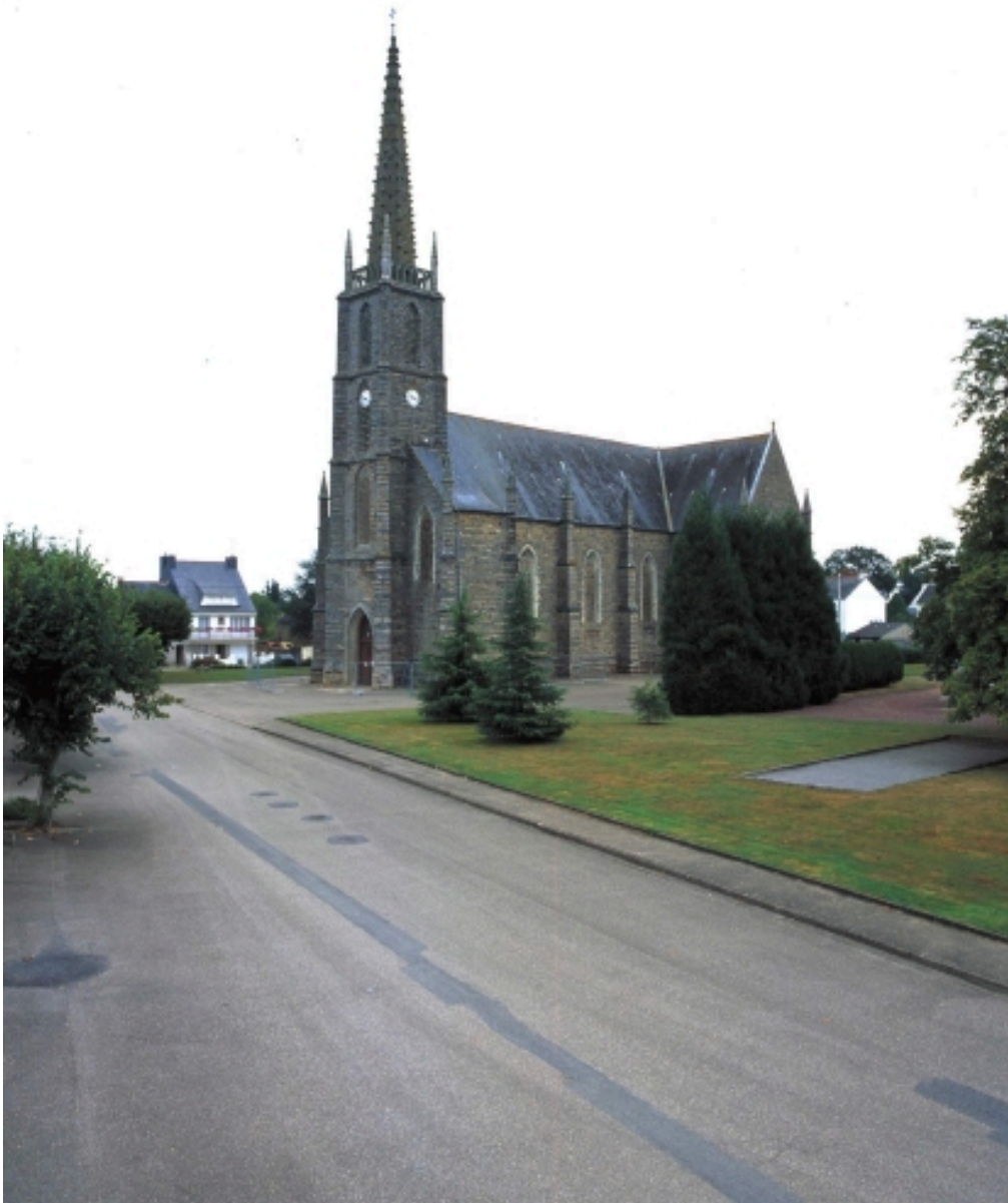
Vue générale : élévation sud-ouest
