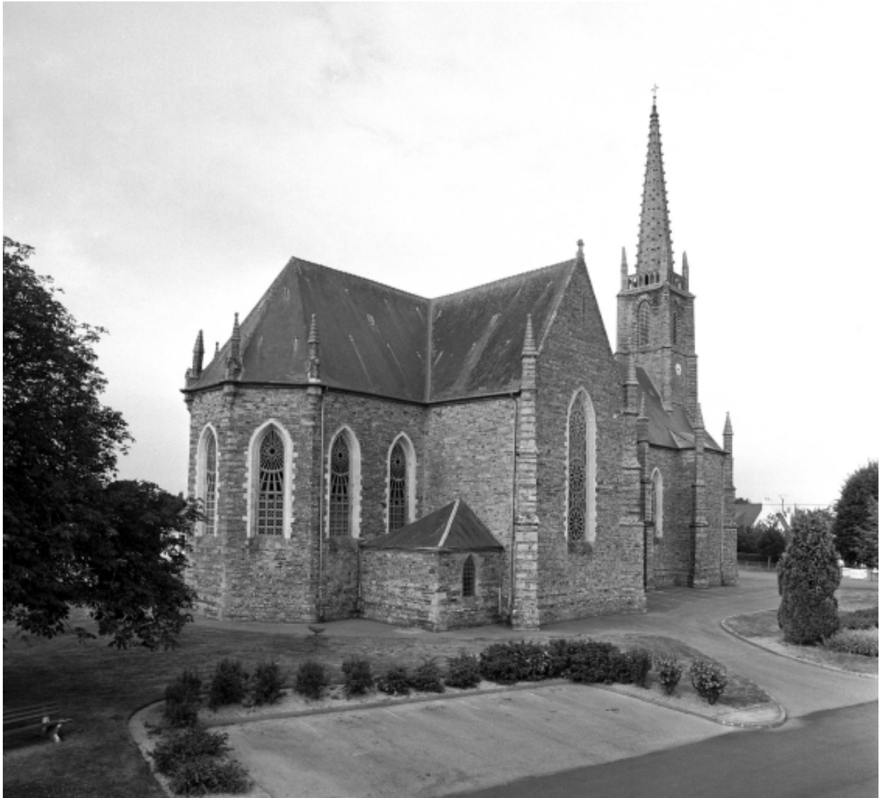
Vue générale : élévation nord-est
