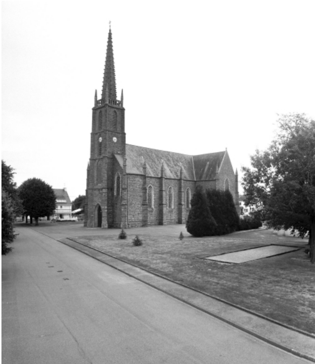
Vue générale : élévation sud-ouest
