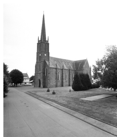
Vue générale : élévation sud-ouest Phot. Auteur inconnu IVR53_19943501730X
