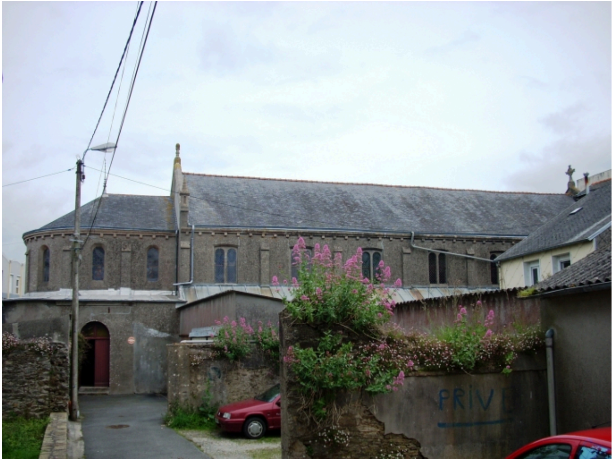
Brest, église Saint-Joseph : vue générale nord
