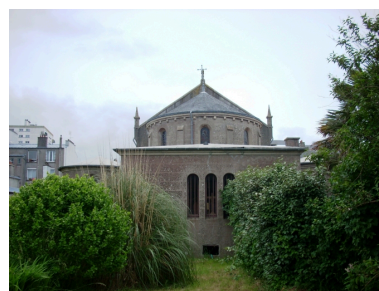
Brest, église Saint-Joseph : élévation est Phot. Gwénaél Fauchille IVR53_20082906031NUCA
