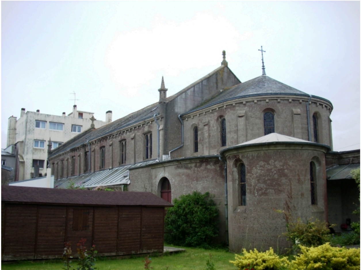
Brest, église Saint-Joseph : vue générale sud-est
