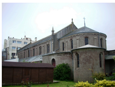
Brest, église Saint-Joseph : vue générale sud-est Phot. Gwénaél Fauchille IVR53_20082906029NUCA
