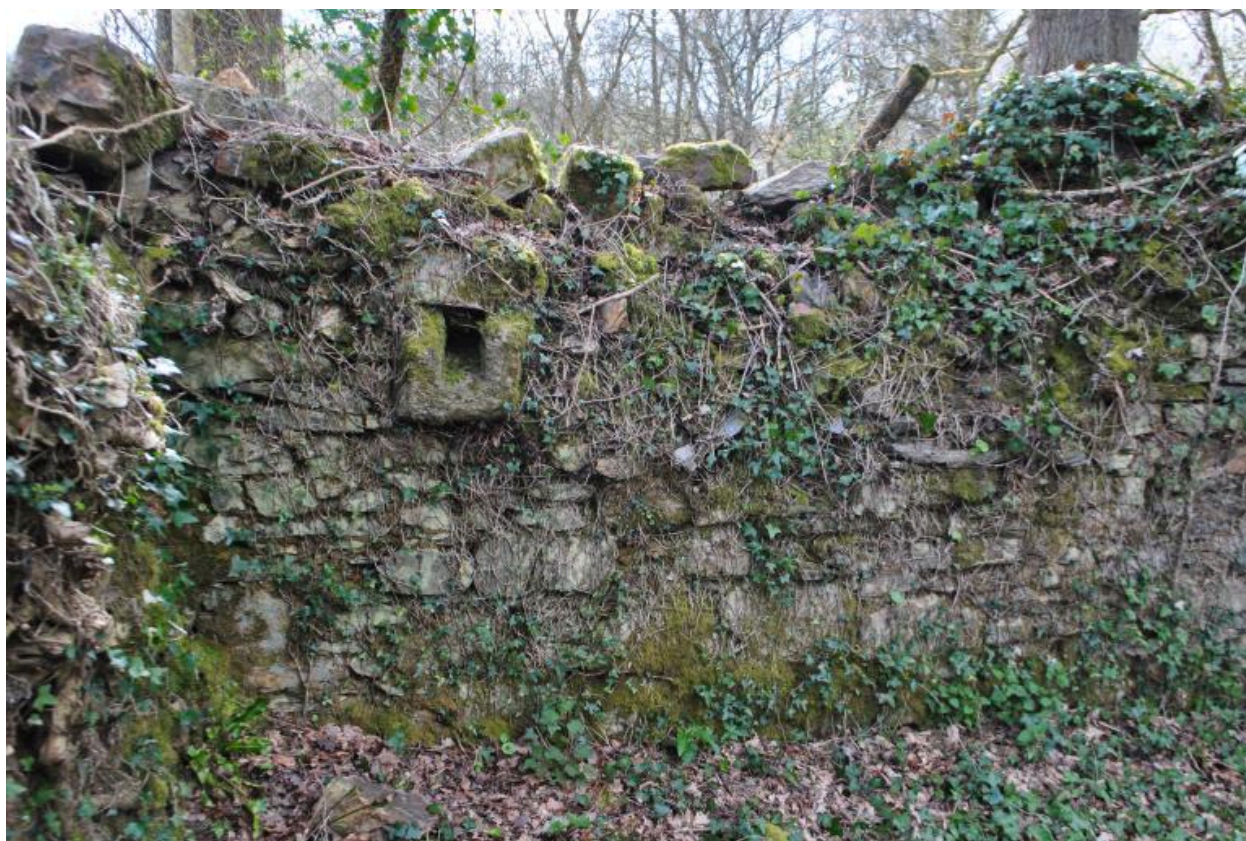
Conduit d'eau en granite de l'ancienne boulangerie médiévale
