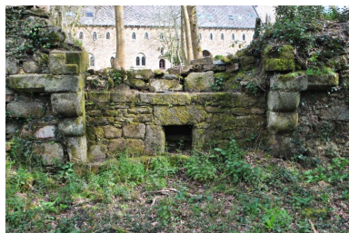
Cheminée à crossettes de l'ancienne boulangerie médiévale Phot. Fadila Hamelin IVR53_20202208139NUCA
