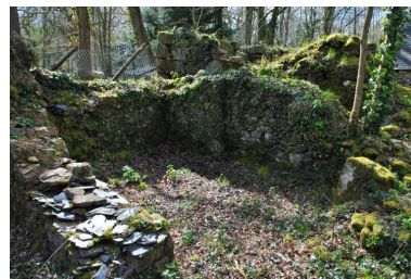
Salle du petit enclos en ruine IVR53_20202208141NUCA
