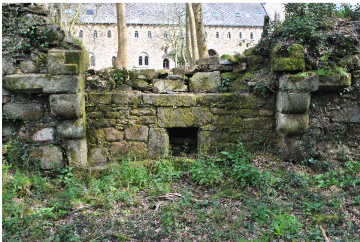
Cheminée à crossettes de l'ancienne boulangerie médiévale
