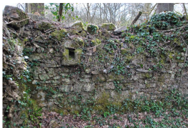
Conduit d'eau en granite de l'ancienne boulangerie médiévale IVR53_20202208140NUCA
