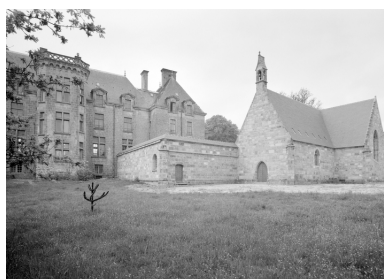
Chapelle du château - Vue générale, faces est et nord Phot. François Dagorn IVR53_19685600003V
