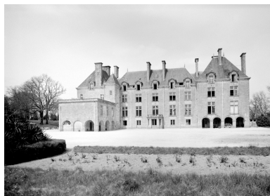
Vue générale avec parterres, prise du sud Phot. François Dagorn IVR53_19675600245V
