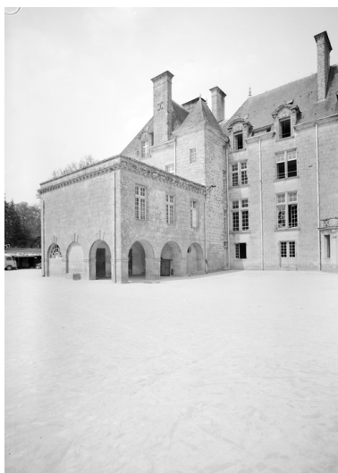
Vue de l'aile ouest (bâtiment à arcades en avant-corps) Phot. François Dagorn IVR53_19675600243V
