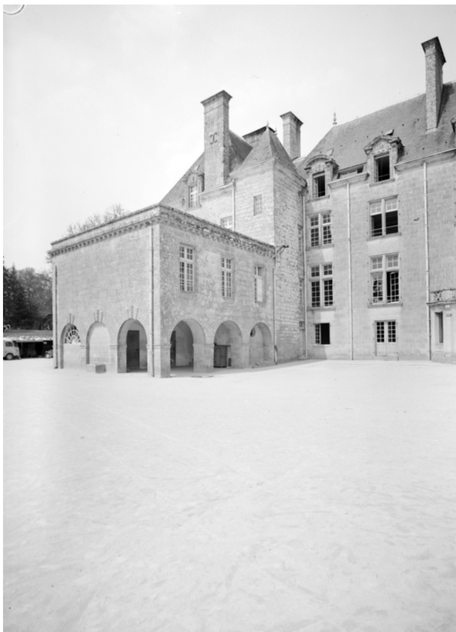
Vue de l'aile ouest (bâtiment à arcades en avant-corps)
