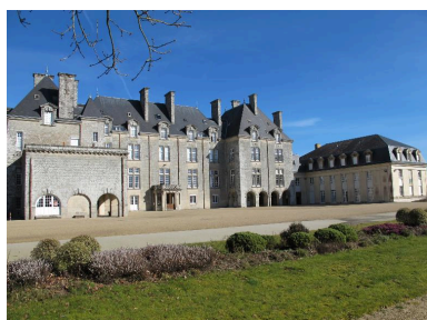
Vue générale sud, état en 2015 Phot. Catherine Toscer IVR53_20155605045NUCA
