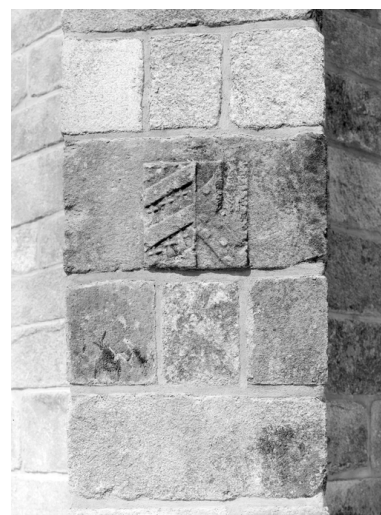
Chapelle du château - Mur ouest, extérieur, blason Phot. François Dagorn IVR53_19685600013V
