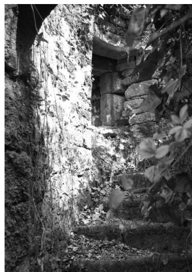
Ruines de l'ancien château - Vue de l'intérieur, fenêtre Phot. François Dagorn IVR53_19675600406Z
