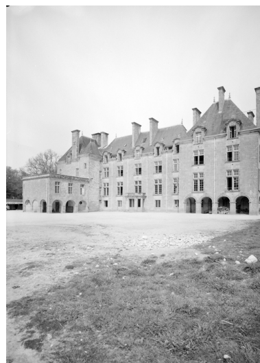
Vue générale prise du sud-est Phot. François Dagorn IVR53_19675600244V
