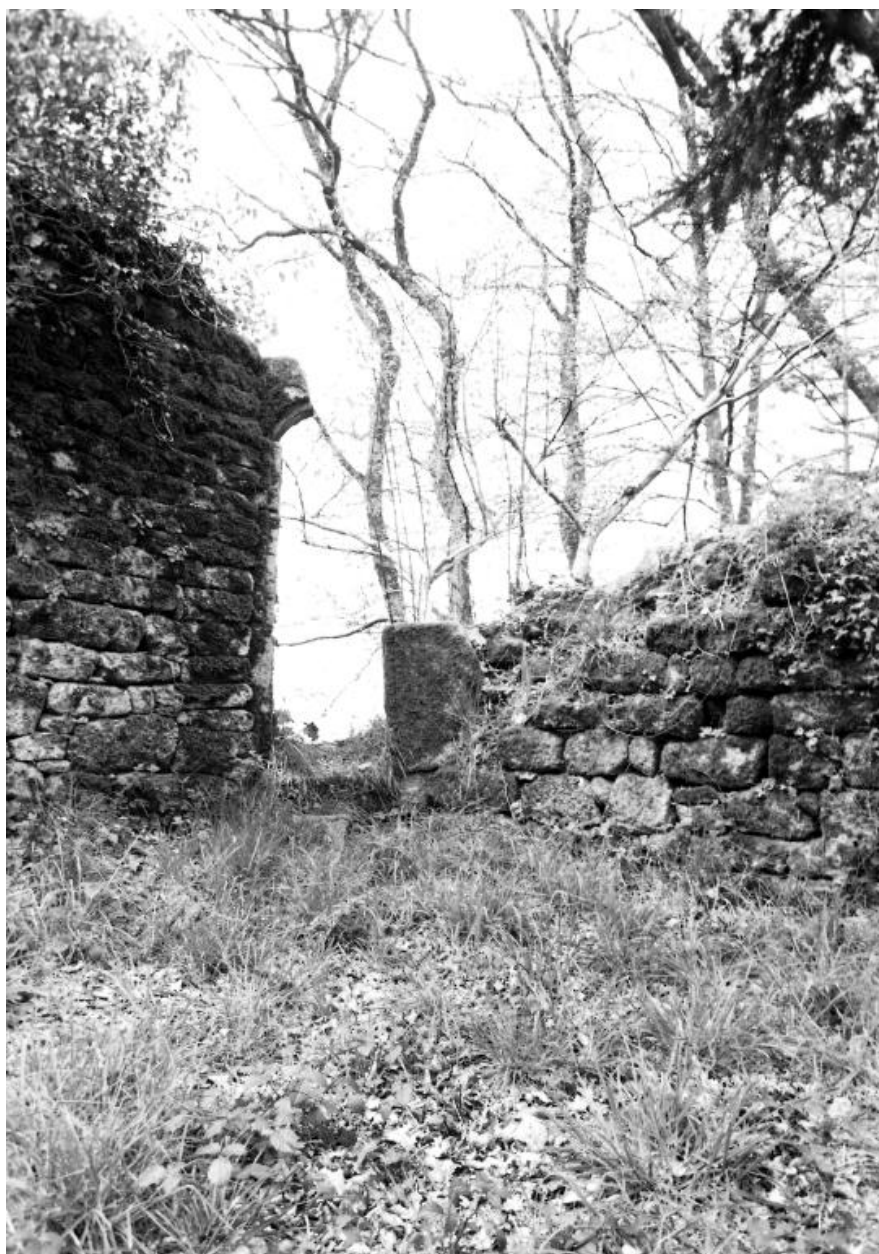
Ruines de l'ancien château - Débris de porte sur le mur est
