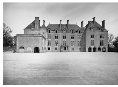
Façade sud, vue d'ensemble Phot. François Dagorn IVR53_19675600241V
