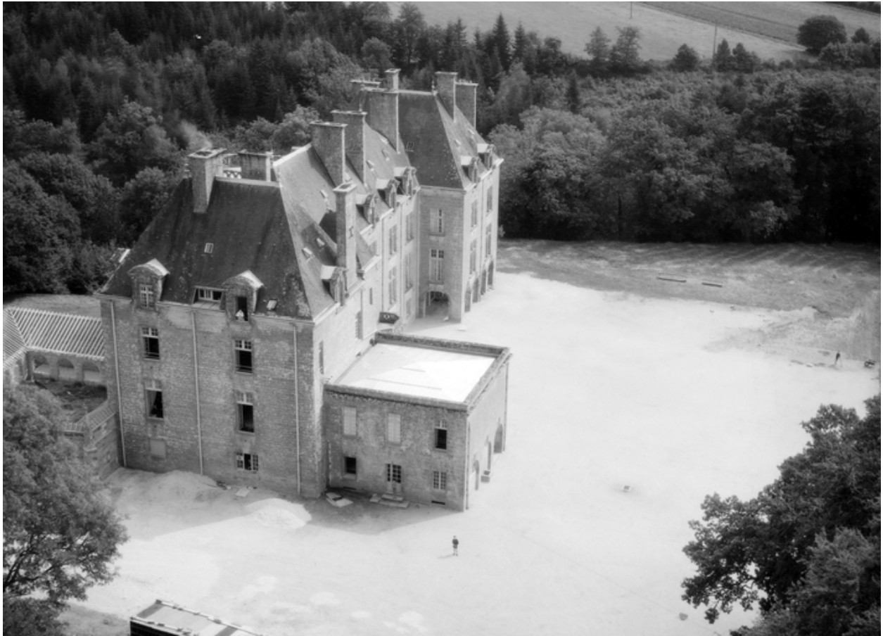
Vue aérienne, face ouest
