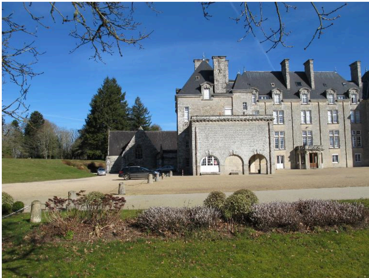
Vue sud du logis et de la chapelle sainte Anne provenant de Pluméliau, état en 2015
