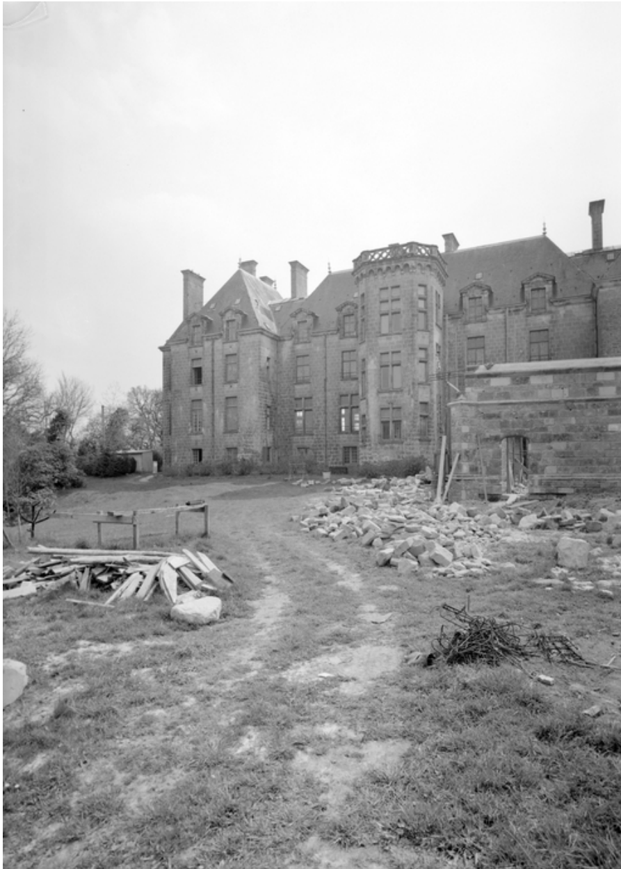
Façade nord, vue générale
