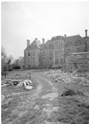
Façade nord, vue générale Phot. François Dagorn IVR53_19675600246V
