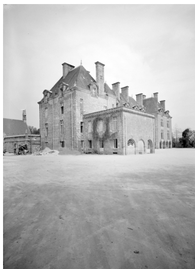
Vue générale prise du sud-ouest Phot. François Dagorn IVR53_19675600242V
