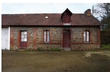
Le logement secondaire : vue générale ouest Phot. Guy Artur, Phot. Norbert Lambart IVR53_20023502545NUCA
