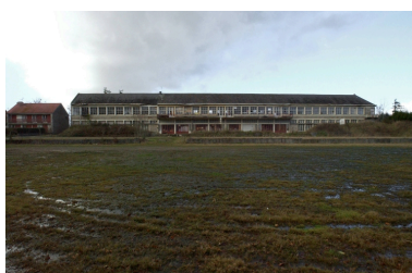
L'aérium : vue générale sud Phot. Guy Artur, Phot. Norbert Lambart IVR53_20023502548NUCA
