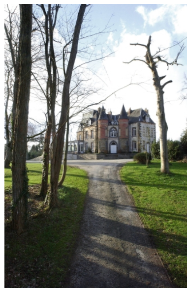
Le château : vue générale sud-est Phot. Guy Artur, Phot. Norbert Lambart IVR53_20023502549NUCA
