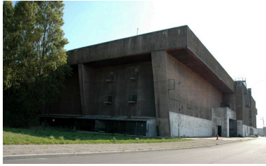
Vue de l'angle ouest : contreforts et dalle de couverture (2005). Les quatre entrées/sorties correspondent à la caserne dite des 1000 Phot. Guillaume Lécueillier IVR53_20055603561NUCA
