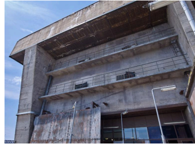
Vue de l'étage de l'alvéole K6a : caserne dite des 1000 (2021) Phot. Bernard Bègne IVR53_20215600543NUCA
