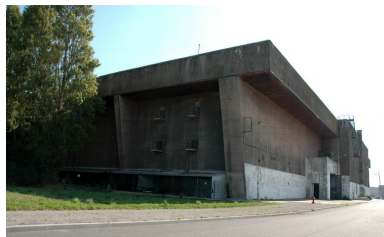
Vue de l'angle ouest : contreforts et dalle de couverture (2005). Les quatre entrées/sorties correspondent à la caserne dite des 1000 Phot. Guillaume Lécueillier IVR53_20055603561NUCA
