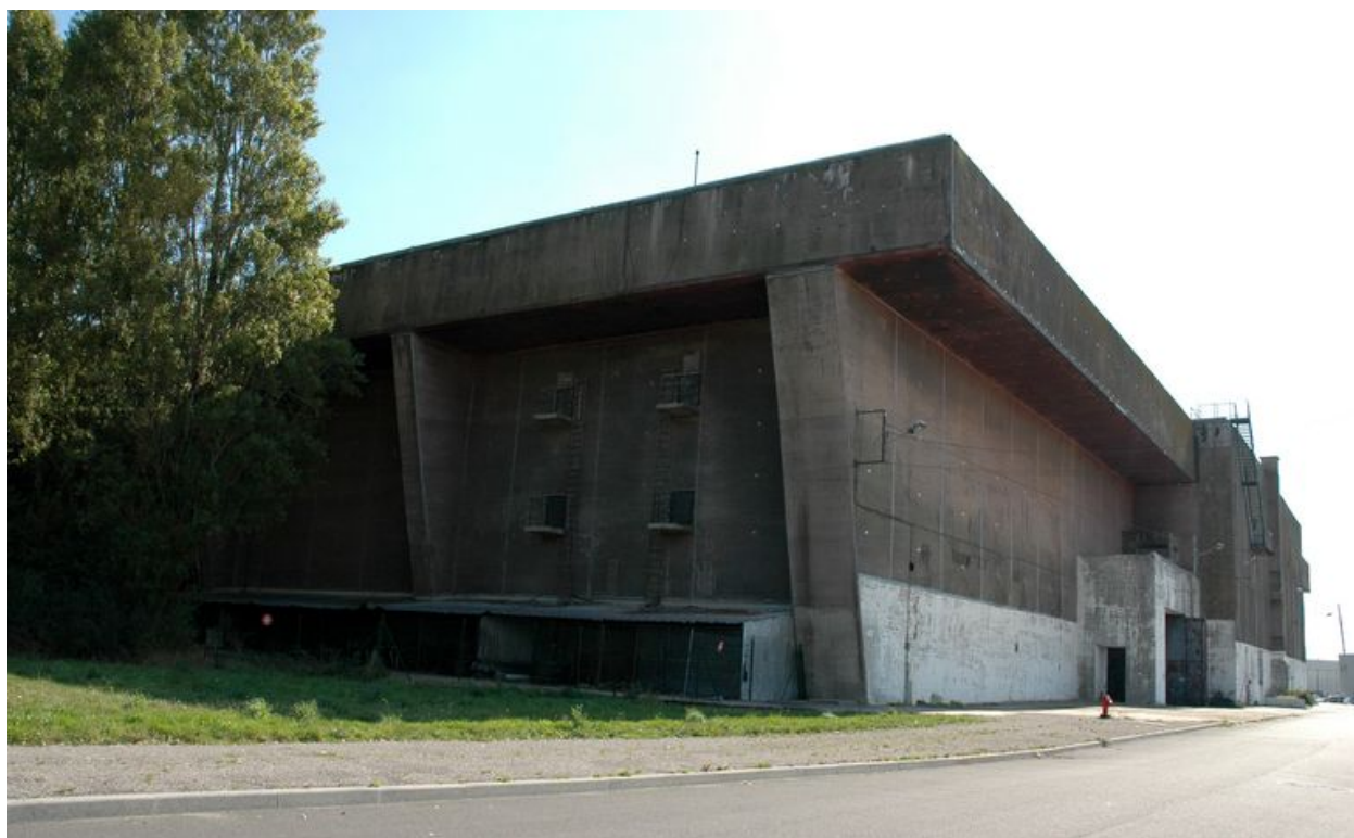
Vue de l'angle ouest : contreforts et dalle de couverture (2005). Les quatres entrées/sorties correspondent à la caserne dite des 1000
