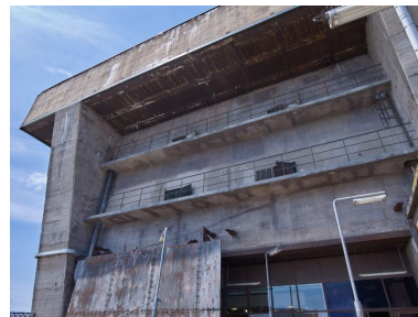
Vue de l'étage de l'alvéole K6a : caserne dite des 1000 (2021) Phot. Bernard Bègne IVR53_20215600543NUCA
