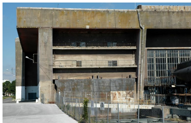
Vue de l'angle sud-ouest : contreforts et dalle de couverture (2005). La première alvéole nommée "K6a" sert d'abri au chariot de translation des sous-marins. Les quatre entrées/sorties situées au premier étage correspondent à la caserne dite des 1000 Phot. Guillaume Lécueillier IVR53_20055603555NUCA
