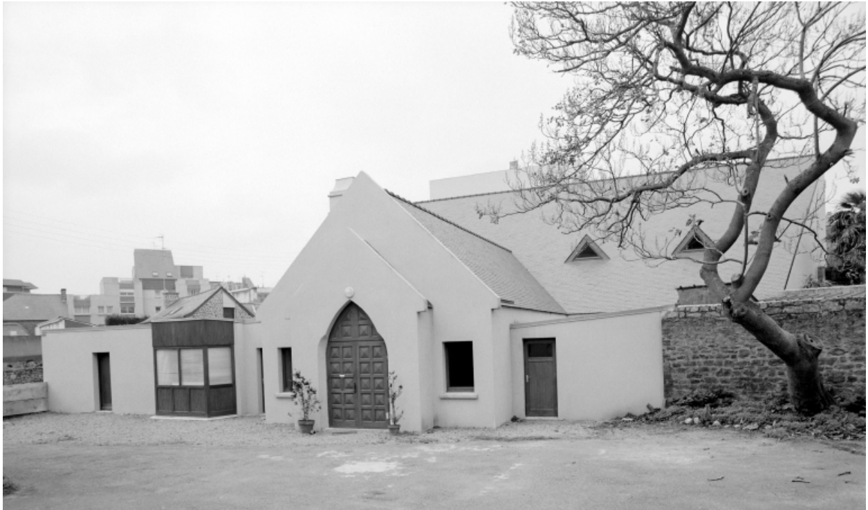
Elévation Est : vue générale
