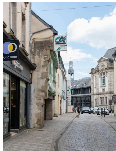
Le mur pignon présente différents ressauts qui accompagnent l'encorbellement du pan de bois. Phot. Léna Leroy IVR53_20255600288NUCA
