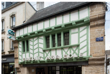
Des chevrons contreventent l'étage tandis que de simples potelets renforcent le surcroît. Phot. Léna Leroy IVR53_20255600285NUCA
