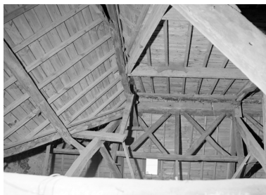
Charpente, étrésolement du sous-faîtage en croix de St-André (état en 1978). Phot. François Dagorn IVR53_19785600696X
