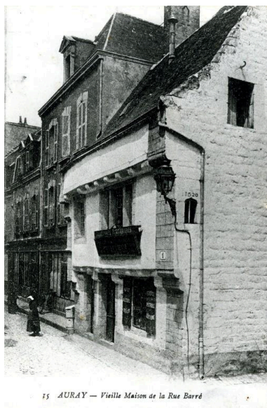
Façade principale en pan de bois recouvert d'un enduit et date de 1620 gravée sur le pignon. Phot. Ville d'Auray IVR53_20245610535NUC
