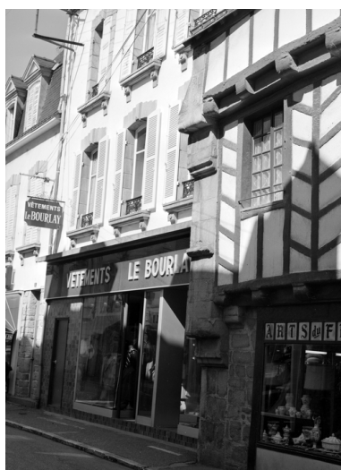
Partie gauche de l'étage en pan de bois, ancré dans un mur à ressauts. Phot. François Dagorn
