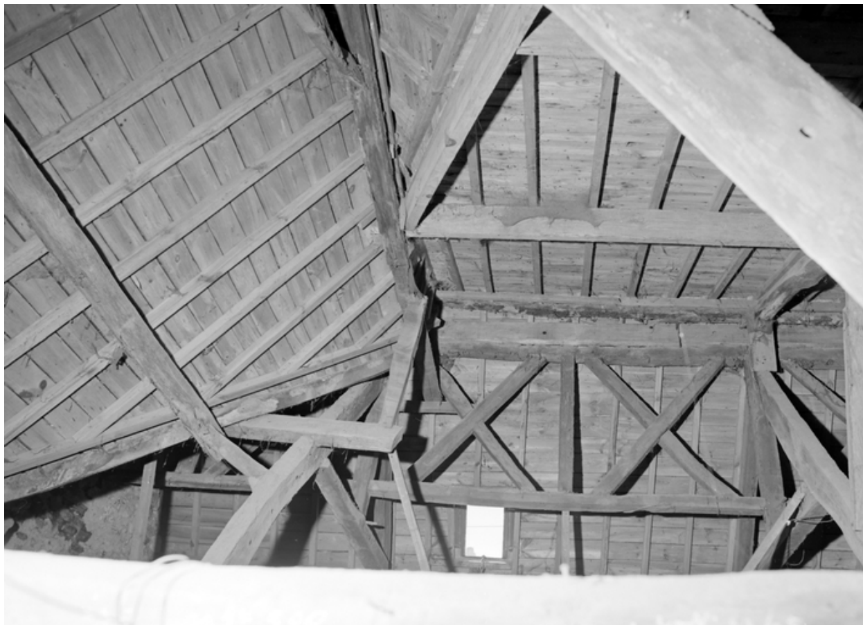
Charpente, étrésillonnement du sous-faîtage en croix de St-André (état en 1978).
