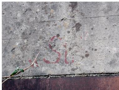
Vue du fronton au-dessus de l'entrée de l'un des bunkers de type 669 : St, abréviation de Ständig Ausbau, construction permanente avec une dalle de couverture et des murs périphériques de 2 m d'épaisseur de béton armé. Ce type de bunker résiste à un bombardement aérien
