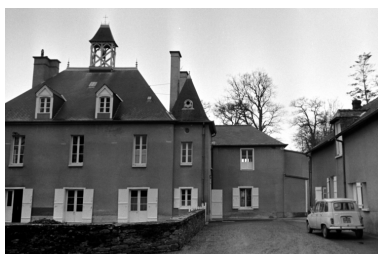
Façade principale Phot. Jeannik Le Goux IVR53_19733505266NUC
