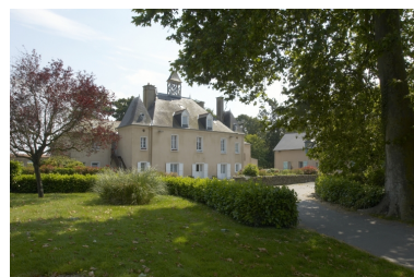
Vue générale Phot. Norbert Lambart IVR53_20083500772NUCA
