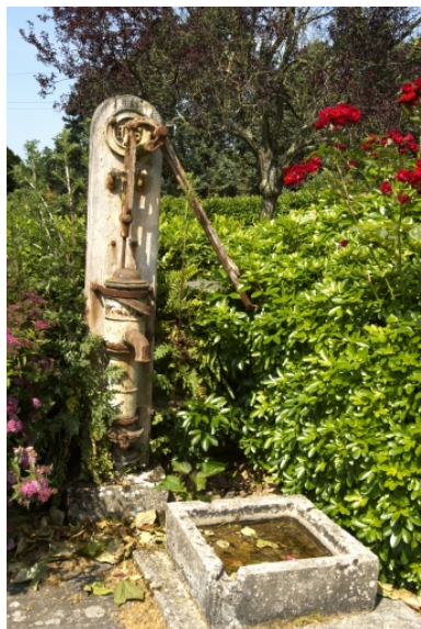
Pompe à eau Phot. Norbert Lambart IVR53_20083500767NUCA
