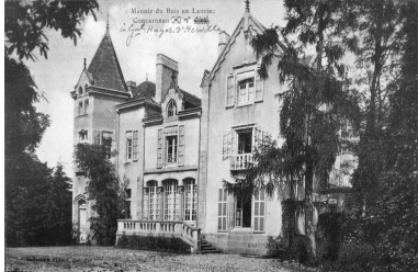
Vue générale Phot. Elise Lauranceau IVR53_20042905514NUCB
