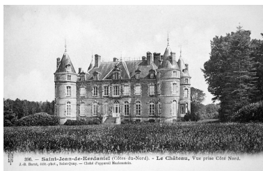
Château : vue générale de la façade nord Phot. Elise Lauranceau IVR53_20042208979NUCB
