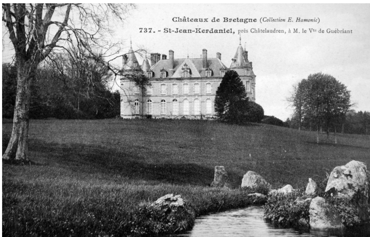
Vue générale de la façade sud
