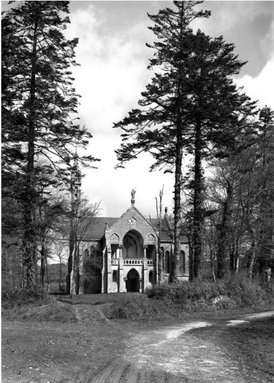
Plomodiern, chapelle Saint-Corentin : vue de situation sud, état en 1970
