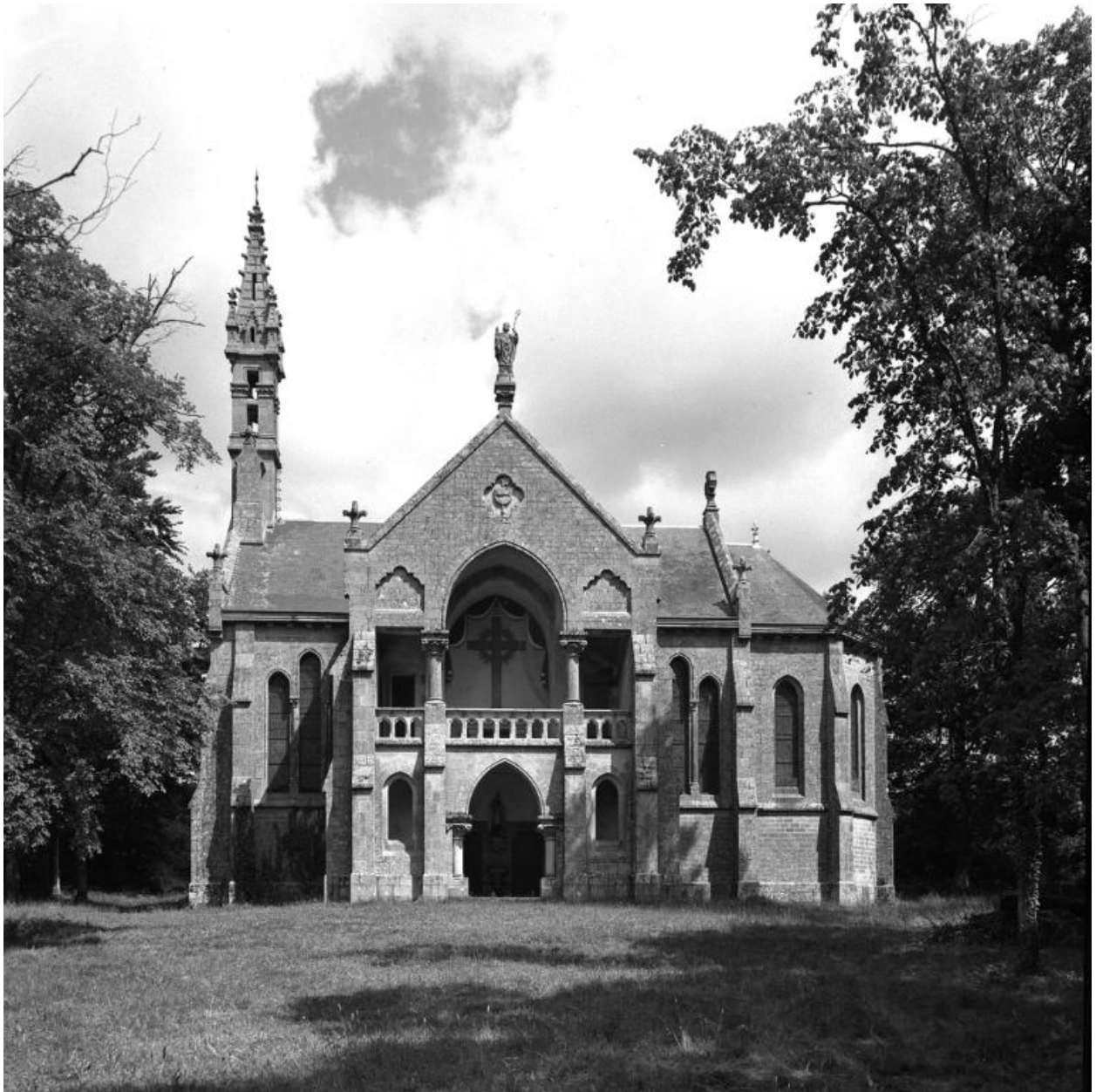
Plomodiern, chapelle Saint-Corentin : façade sud, état en 1970
