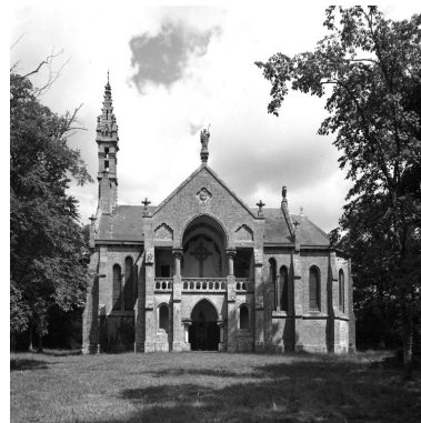
Plomodiern, chapelle Saint- Corentin : façade sud, état en 1970 Phot. François Dagorn IVR53_19702900468V
