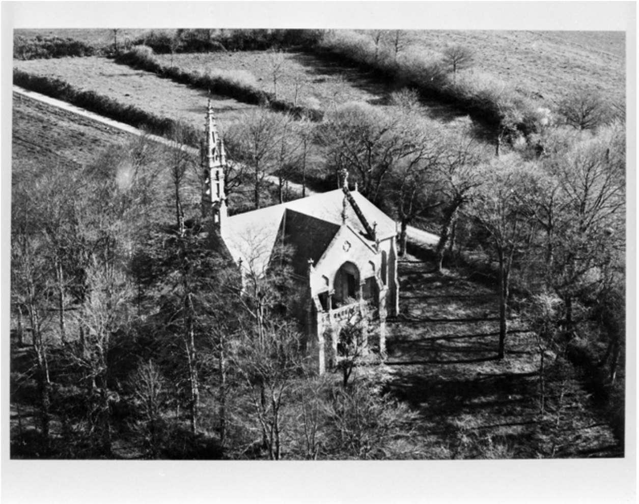
Plomodiern, chapelle Saint-Corentin : vue aérienne sud-ouest, état en 1977
