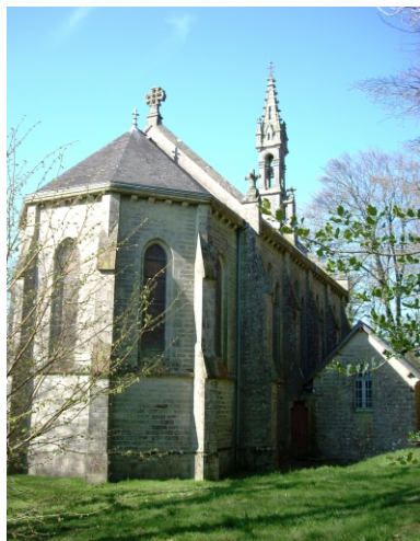
Plomodiern, chapelle Saint-Corentin : vue générale nord-est Phot. Gwénaél Fauchille IVR53_20082905655NUCA
