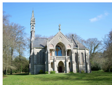
Plomodiern, chapelle Saint- Corentin : vue générale sud Phot. Gwénaél Fauchille IVR53_20082905495NUCA
