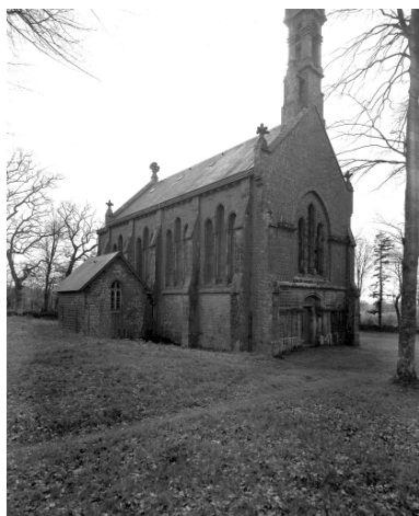
Plomodiern, chapelle Saint-Corentin : vue générale nord-ouest, état en 1970 Phot. François Dagorn IVR53_19702900470V
