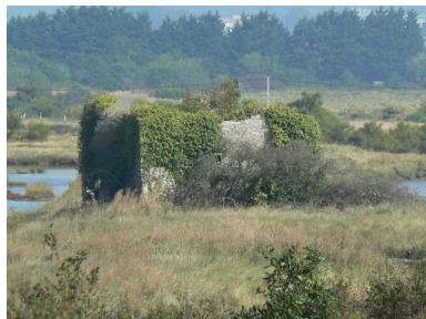
Vue générale du grenier à sel dit salorge de Michotte Phot. Johan Vincent IVR53_20075605767NUCA
