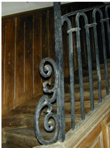
Logis, intérieur, rez-de-chaussée, rampe de l'escalier en fer forgé : détail Phot. Xavier Gilbert IVR53_20023511346NUCA
