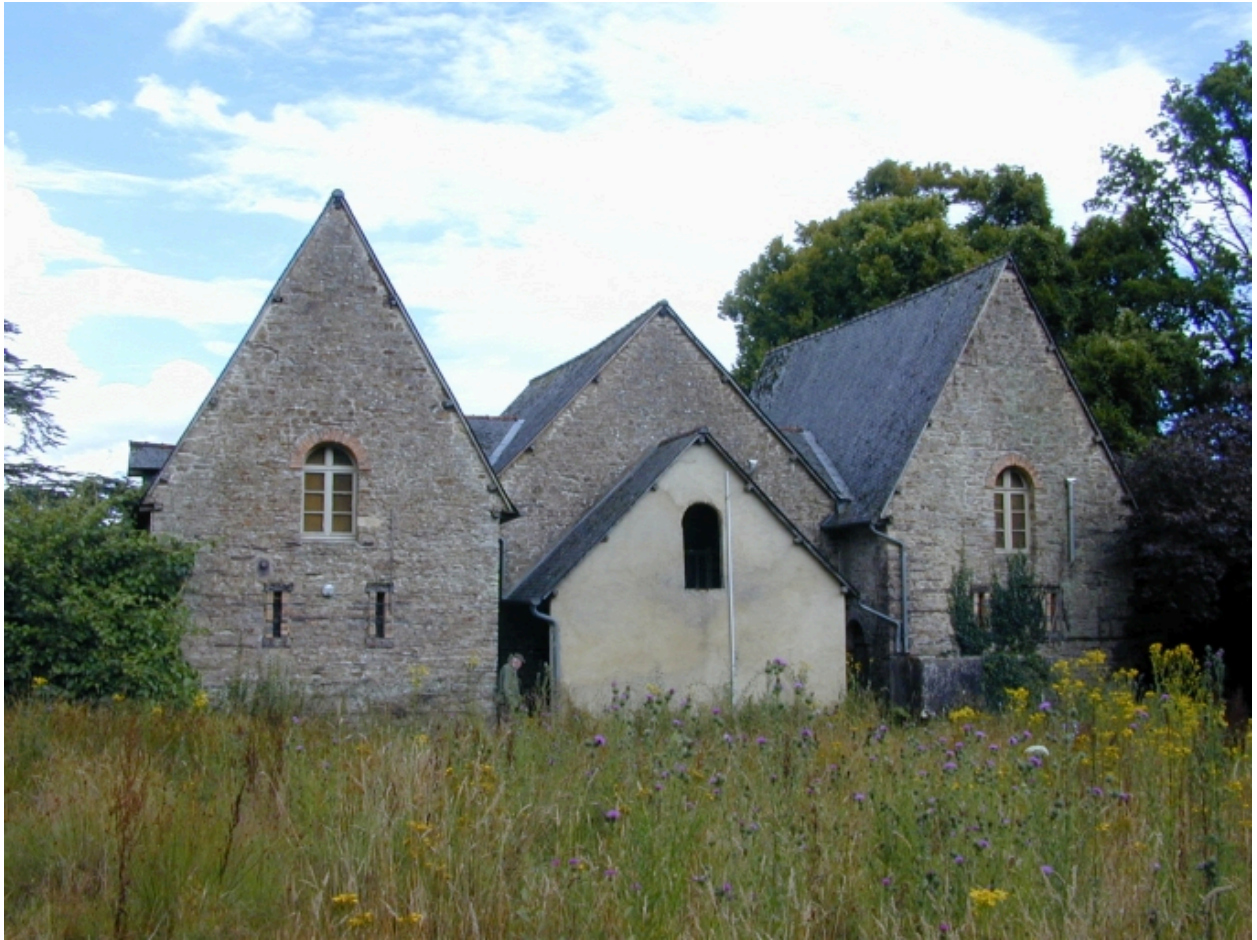
Les communs : vue générale ouest
