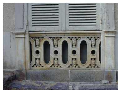
Le logis, rez-de-chaussée, balustrade de tuffeau : vue générale sud Phot. Xavier Gilbert IVR53_20023511338NUCA
