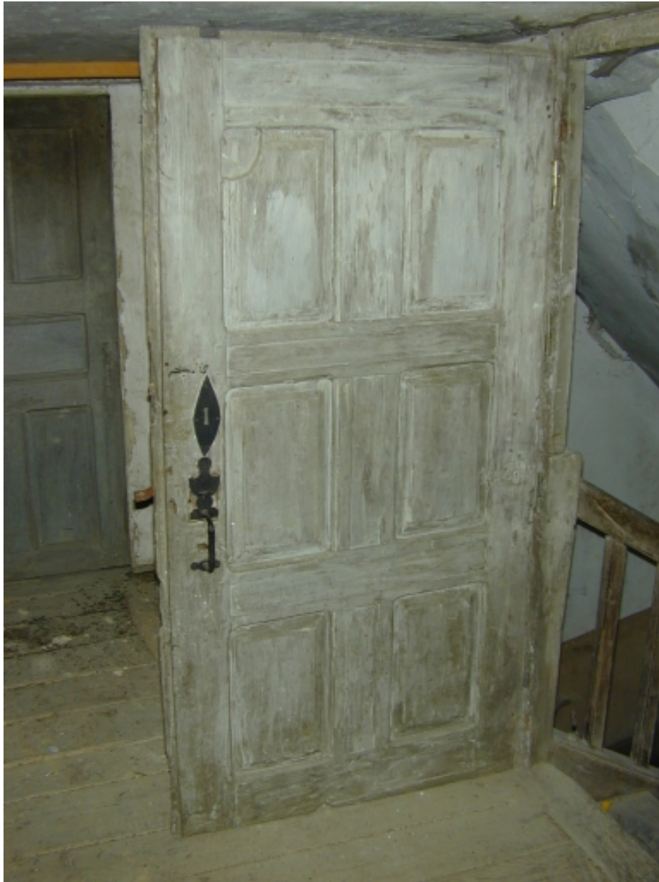
Logis, intérieur, porte des combles : vue générale
