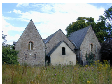
Les communs : vue générale ouest Phot. Xavier Gilbert IVR53_20023511341NUCA
