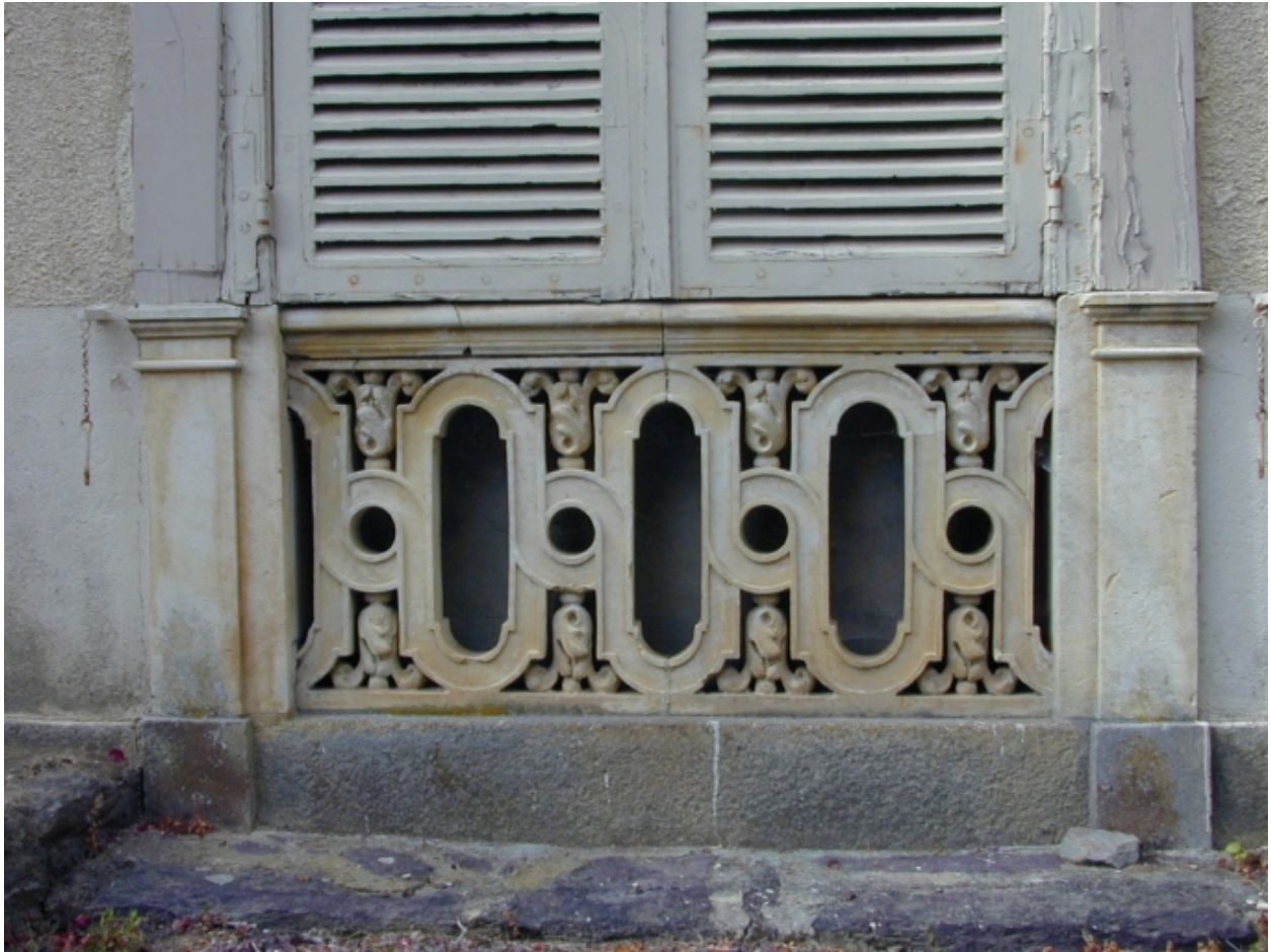
Le logis, rez-de-chaussée, balustrade de tuffeau : vue générale sud
