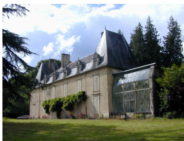
Vue générale sud-est Phot. Xavier Gilbert IVR53_20023511336NUCA
