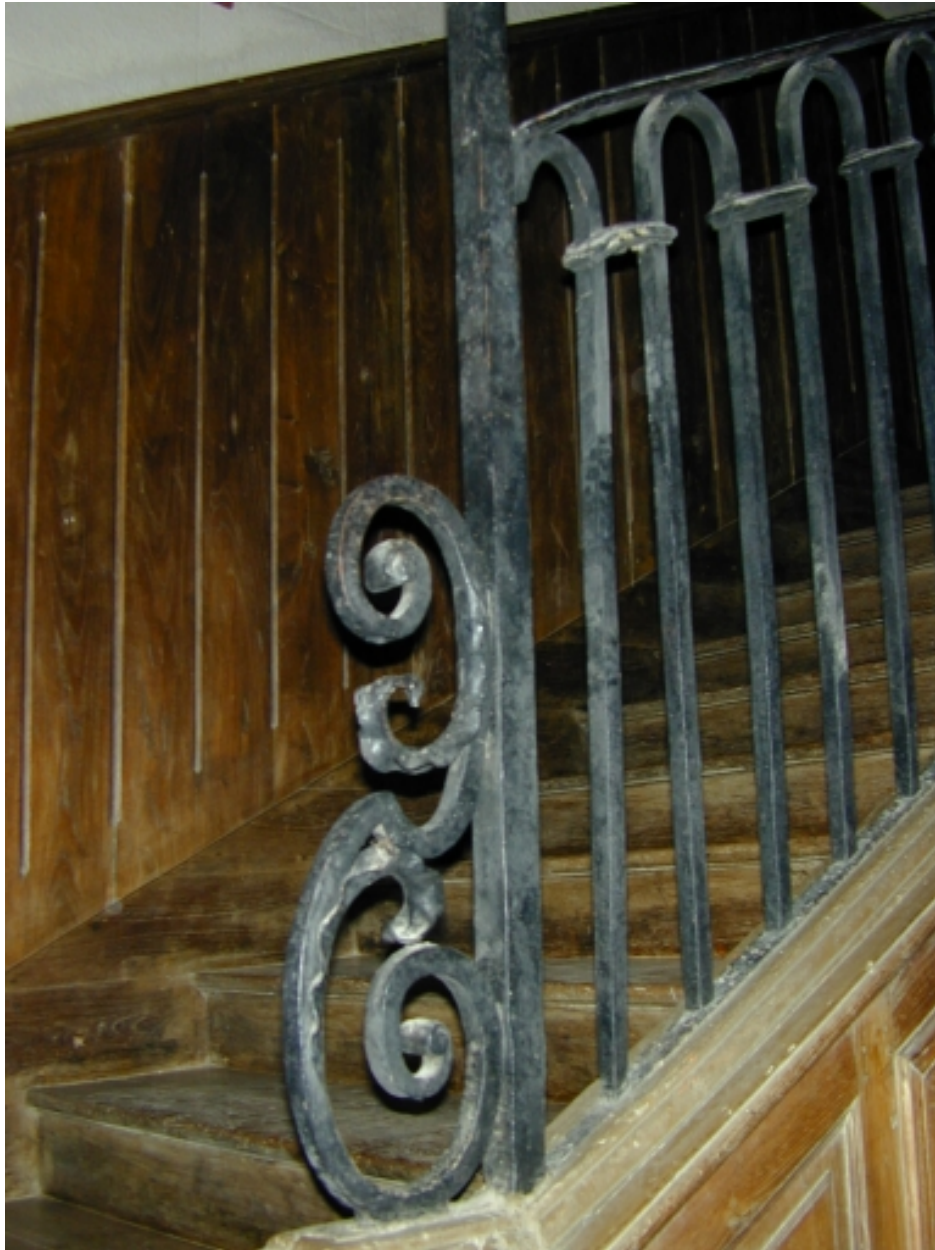
Logis, intérieur, rez-de-chaussée, rampe de l'escalier en fer forgé : détail
