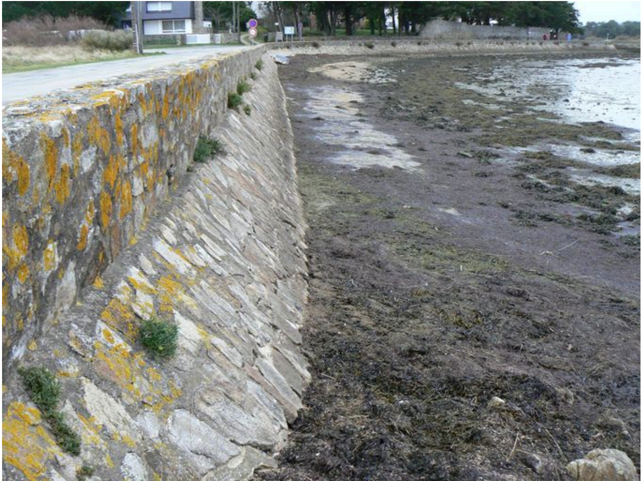
Digue de la Garenne
