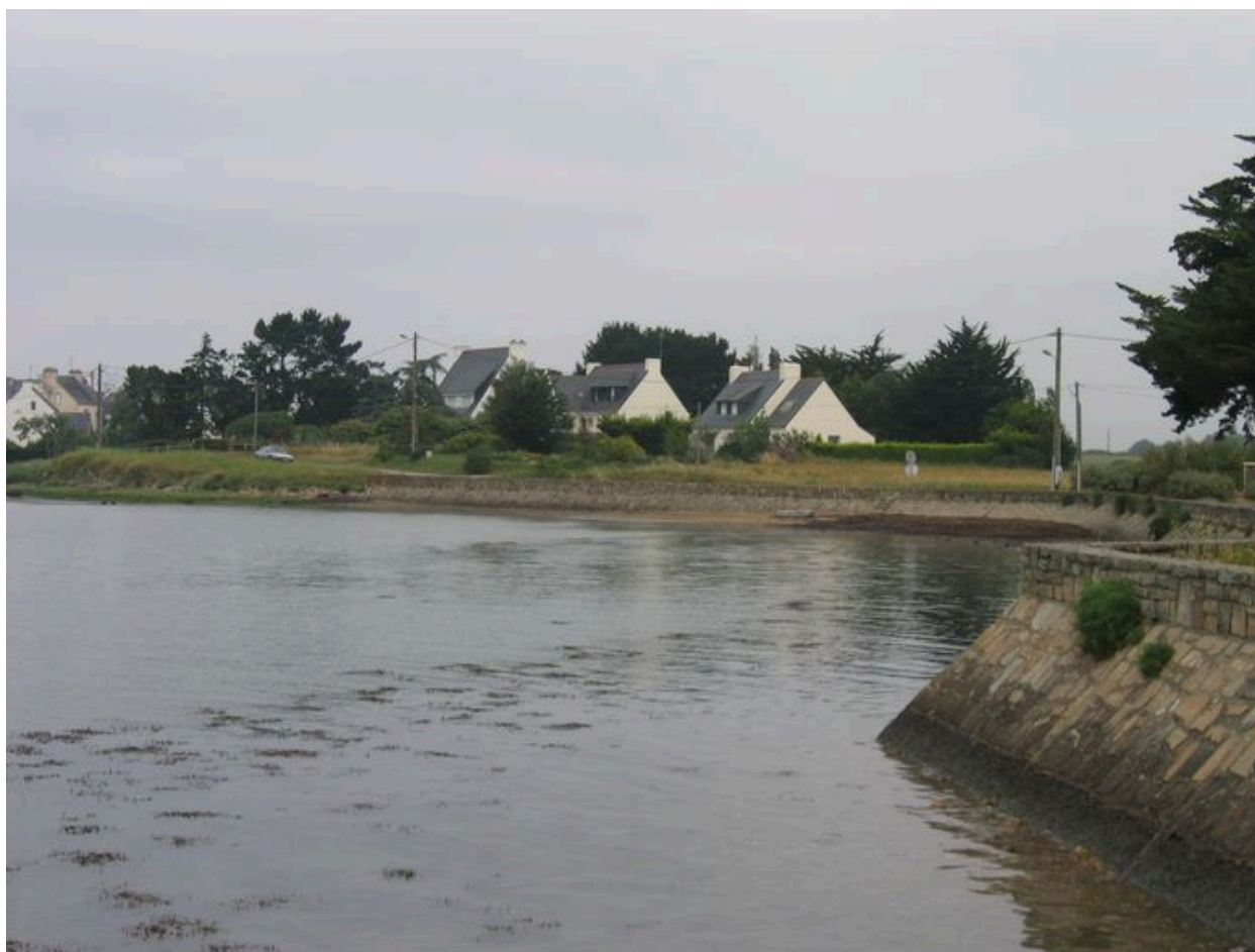
Digue de la Garenne
