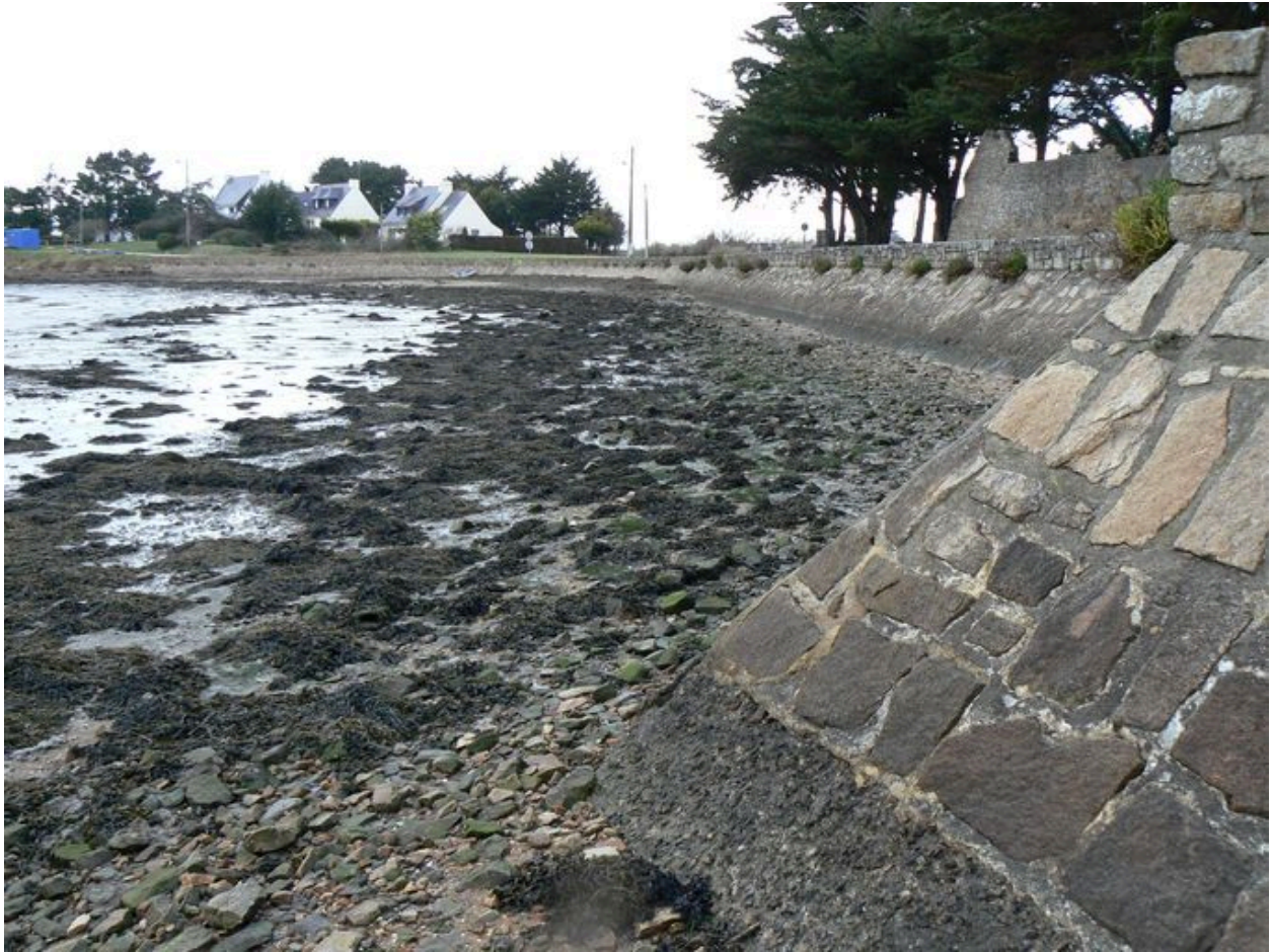
Digue de la Garenne
