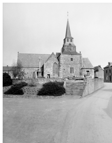
Elévation Sud : vue générale Phot. Guy Artur, Phot. Norbert Lambart IVR53_19943500719X
