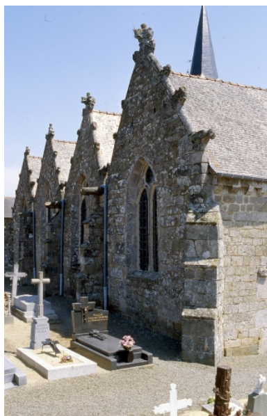
Elévation nord Phot. Auteur inconnu IVR53_19943501159ZA
