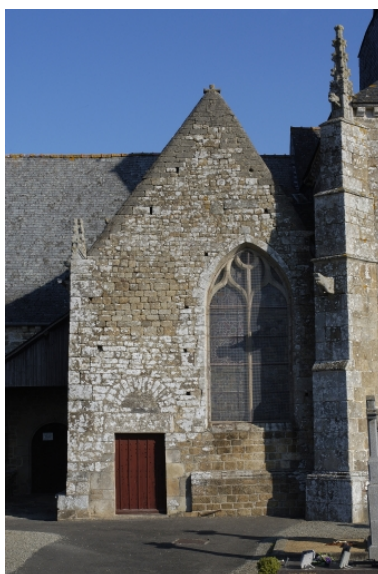
Chapelle sud Phot. Bernard Bègne IVR53_20063500531NUCA
