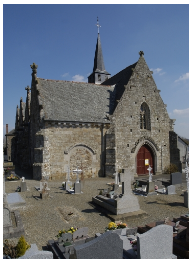
Vue ouest de l'église Phot. Bernard Bègne IVR53_20063500544NUCA
