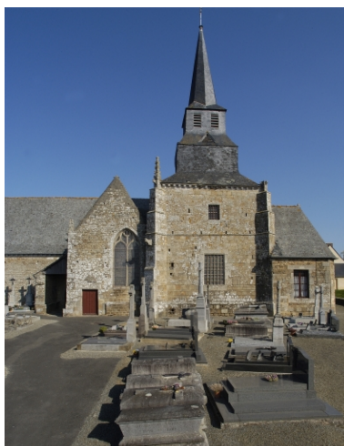
Vue générale sud Phot. Bernard Bègne IVR53_20063500548NUCA
