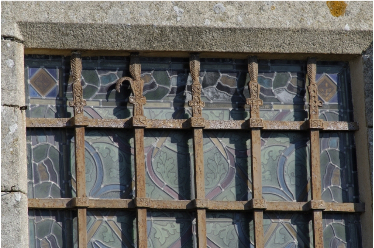
Détail de la grille forgée fenêtre sud
