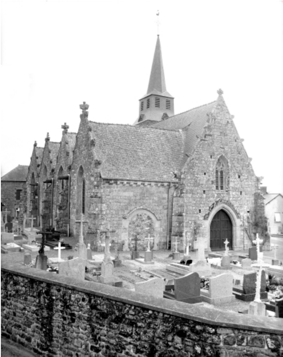
Elévation Nord-Ouest : vue générale
