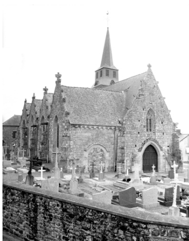
Elévation Nord-Ouest : vue générale Phot. Guy Artur, Phot. Norbert Lambart IVR53_19943500721X
