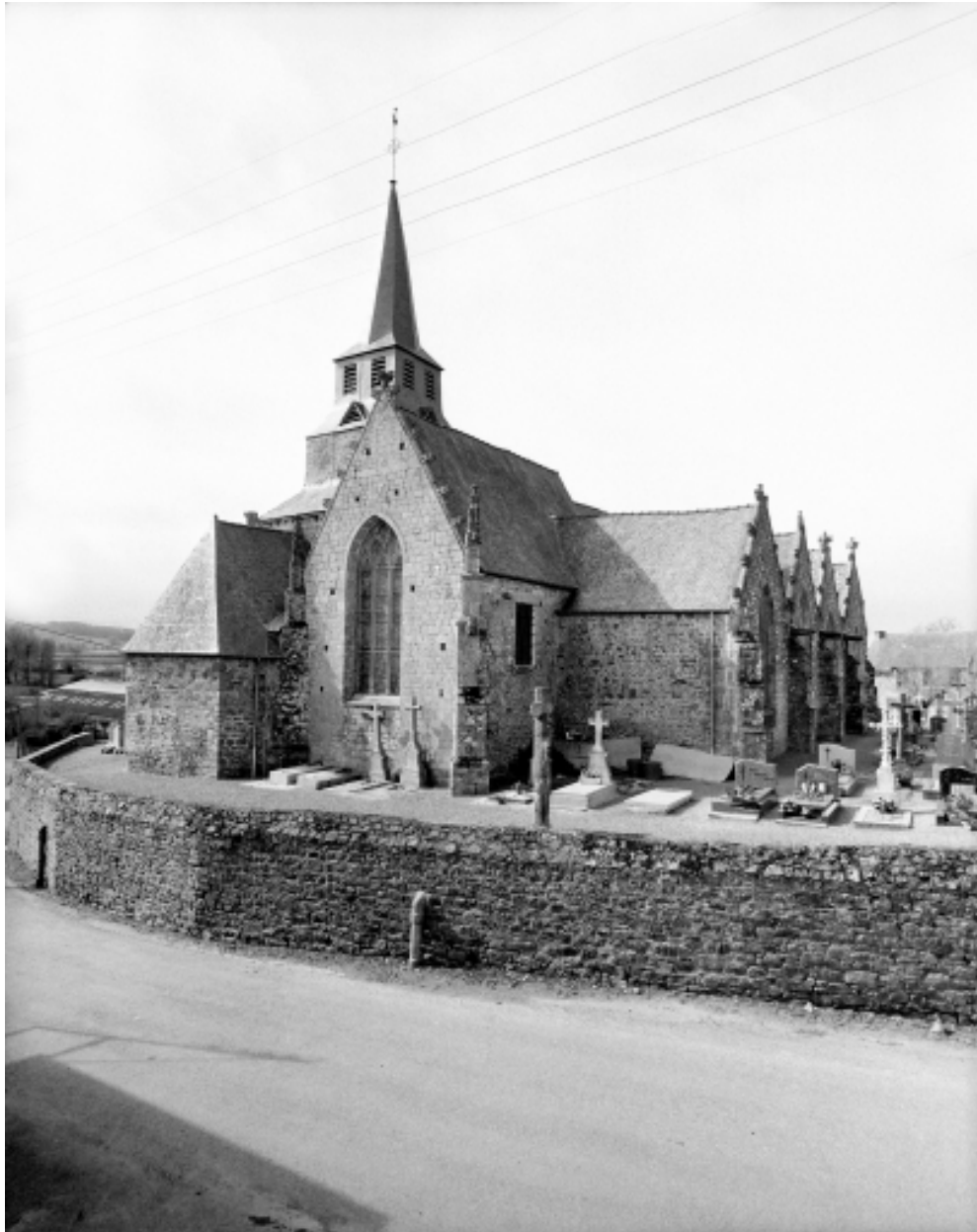
Elévation Nord-Est : vue générale
