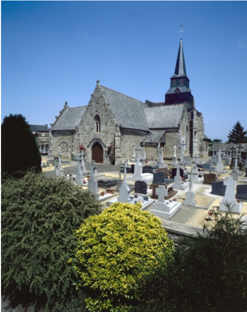
Elévation Sud-Ouest : vue générale
