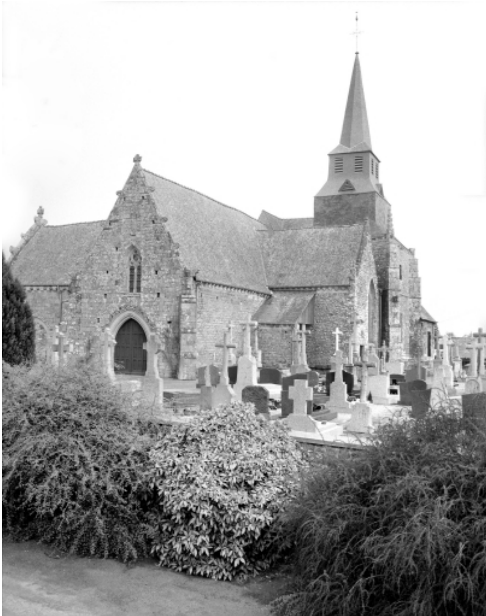
Elévation Sud-Ouest : vue générale
