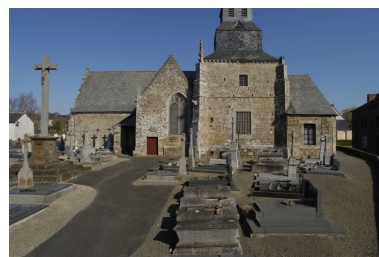
Vue générale sud Phot. Bernard Bègne IVR53_20063500549NUCA
