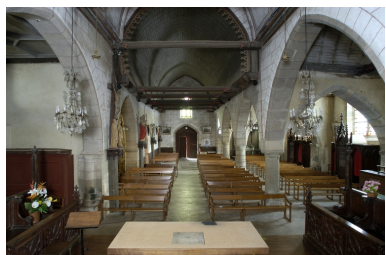
Vue intérieure prise du chœur vers la nef Phot. Bernard Bègne IVR53_20063500149NUCA
