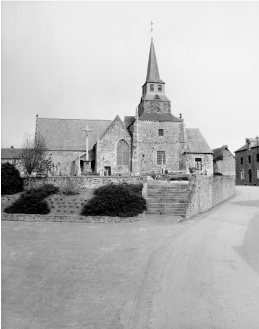
Elévation Sud : vue générale
