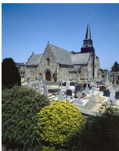
Elévation Sud-Ouest : vue générale Phot. Guy Artur, Phot. Norbert Lambart IVR53_19953500417XA
