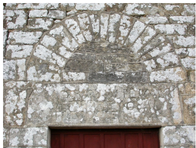
Détail : inscriptions sur la façade Phot. Sabrina Dalibard IVR53_20063508207NUCA
