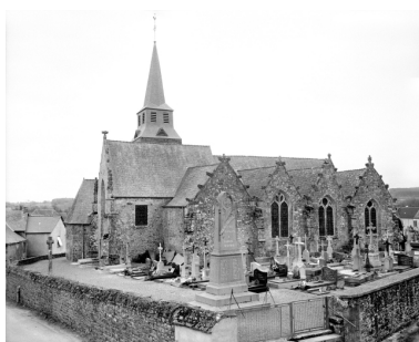
Elévation Nord : vue générale Phot. Guy Artur, Phot. Norbert Lambart IVR53_19943500716X
