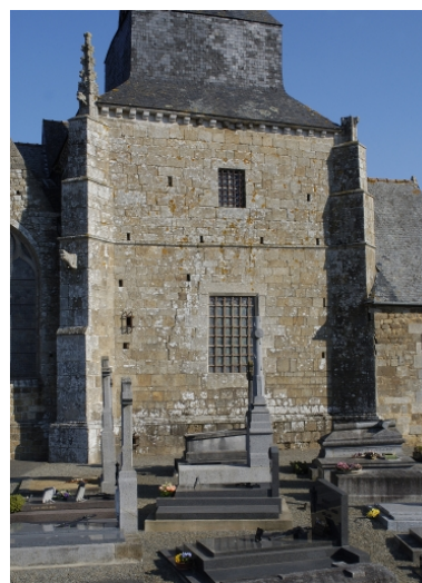
Détail base du clocher Phot. Bernard Bègne IVR53_20063500532NUCA
