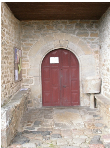
Porte sous porche Phot. Sabrina Dalibard IVR53_20063508206NUCA
