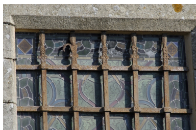
Détail de la grille forgée fenêtre sud Phot. Bernard Bègne IVR53_20063500533NUCA
