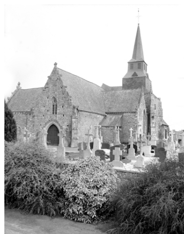
Elévation Sud-Ouest : vue générale Phot. Guy Artur, Phot. Norbert Lambart IVR53_19943500720X
