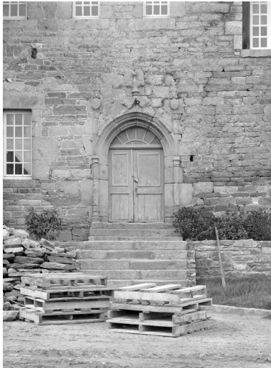
Détail lucarne du mur sud de la façade Phot. Guy Artur IVR53_19772200031V
