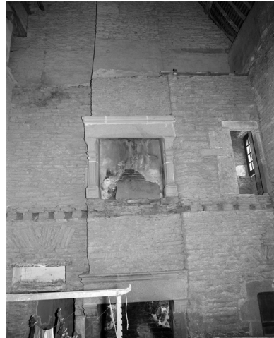
Cheminée du premier étage dans la pièce A Phot. Guy Artur IVR53_19742200350X
