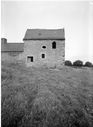
Chapelle : face ouest Phot. Service régional de l'Inventaire de Bretagne IVR53_19742200337V
