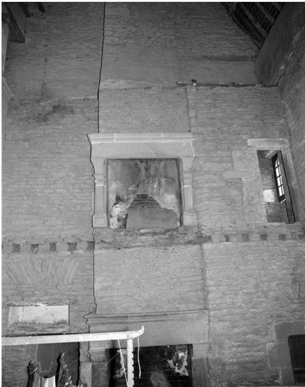
Cheminée du premier étage dans la pièce A
