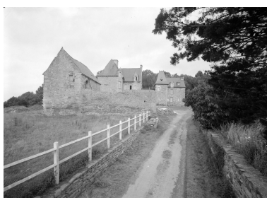
Vue de situation Phot. Guy Artur IVR53_19742200404V
