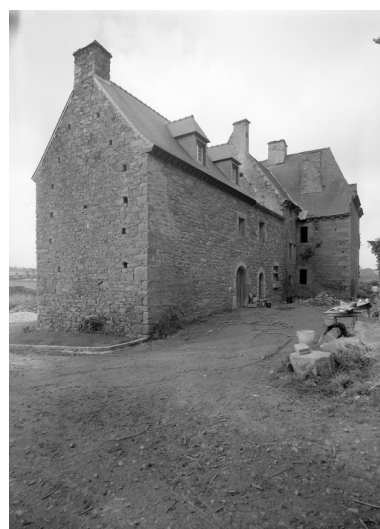
Vue vers le nord-est Phot. Guy Artur IVR53_19742200405V
