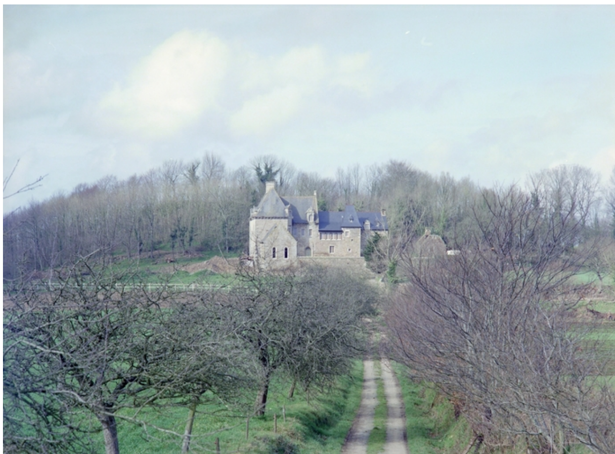
Vue de situation prise du sud, sud-est prise de la route
