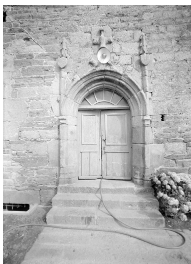
Détail porte sud Phot. Guy Artur IVR53_19742200403V
