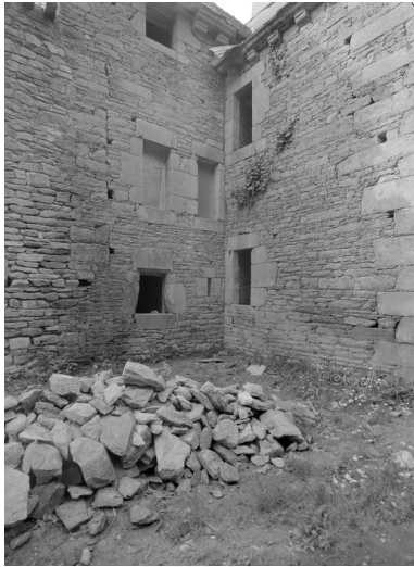
Détail nord Phot. Guy Artur IVR53_19742200406V
