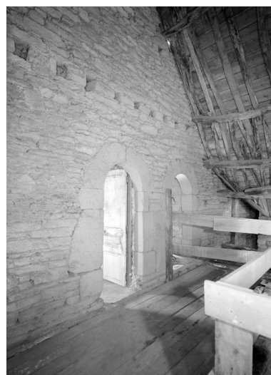
Porte et pigeonnier dans les combles Phot. Guy Artur IVR53_19742200356V
