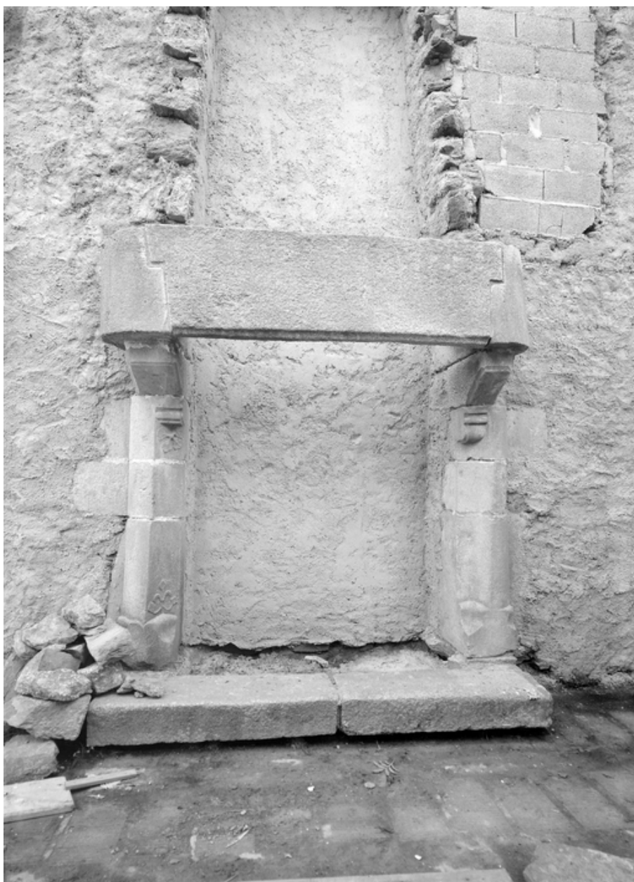
Cheminée au premier étage
