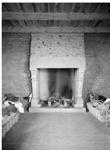
Cheminée du premier étage Phot. Guy Artur IVR53_19742200354V
