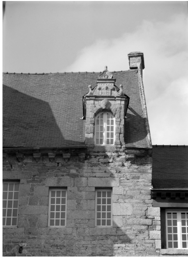
Détail lucarne sud Phot. Guy Artur IVR53_19742200407V
