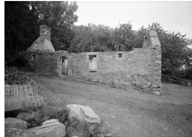
Commun : face ouest Phot. Service régional de l'Inventaire de Bretagne IVR53_19742200339V
