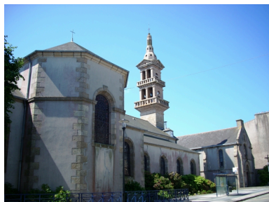
Brest, église Saint-Joseph : vue générale nord-est Phot. Gwénaél Fauchille IVR53_20082906037NUCA
