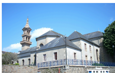
Brest, église Saint-Joseph : vue générale sud-est Phot. Gwénaél Fauchille IVR53_20082906034NUCA
