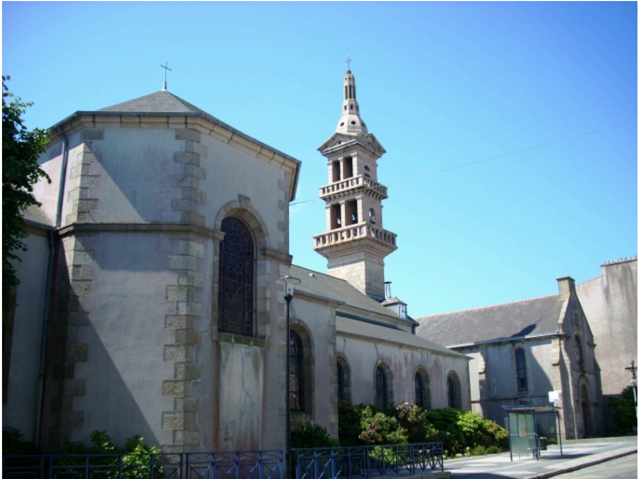
Brest, église Saint-Joseph : vue générale nord-est
