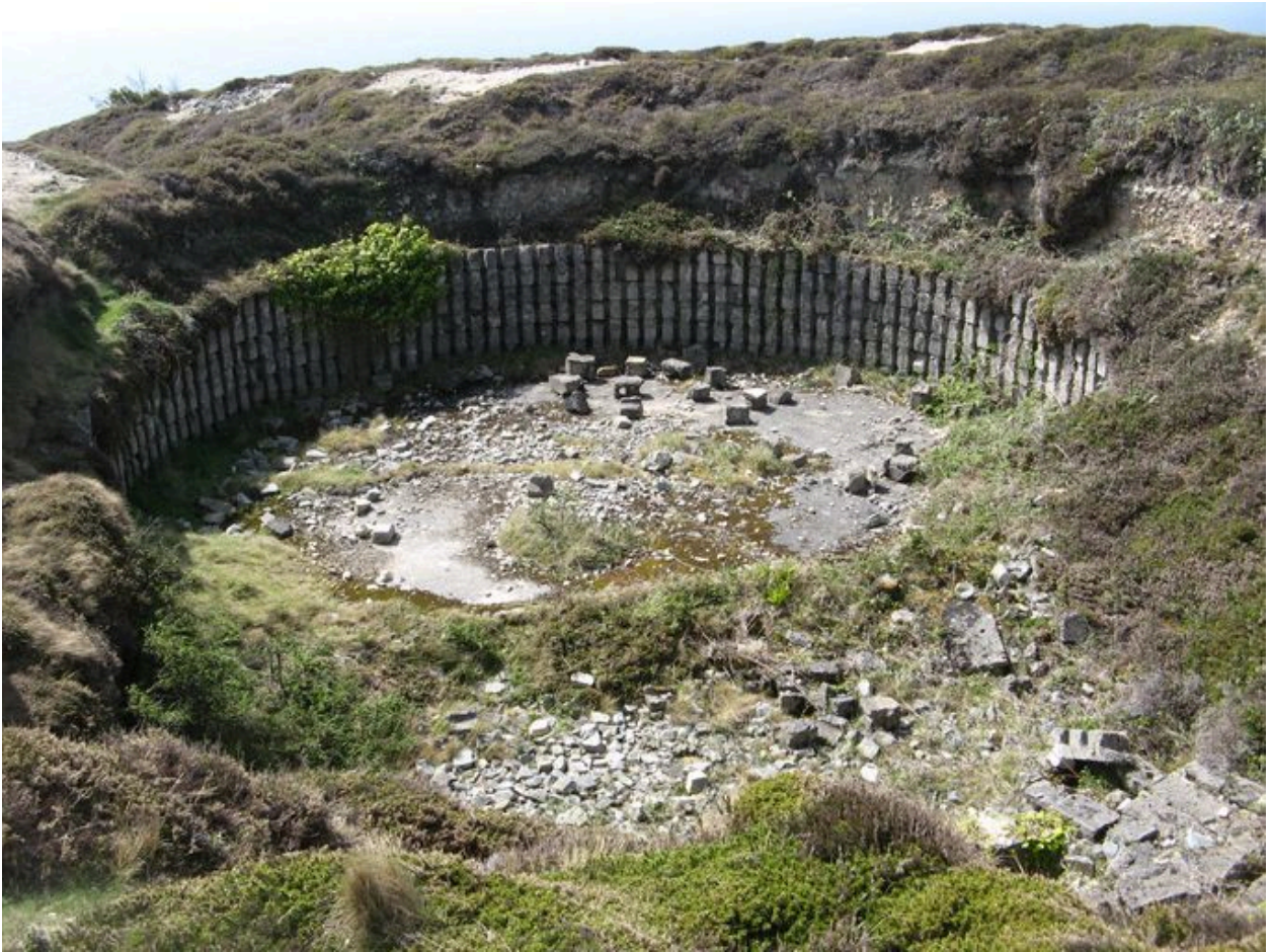
Encuvement du bloc est de la batterie du cap de la Chèvre
