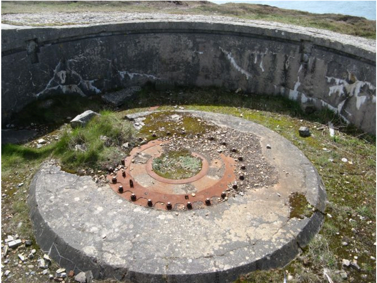
Encuvement du bloc ouest de la batterie du cap de la Chèvre
