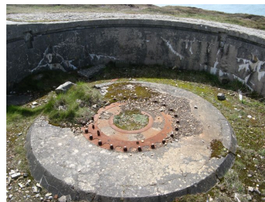
Encuvement du bloc ouest de la batterie du cap de la Chèvre Phot. Guillaume Marie IVR53_20082908326NUCA
