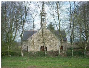
Briec, chapelle Notre-Dame d'Illijour : élévation ouest Phot. Gwénaél Fauchille IVR53_20082905490NUCA
