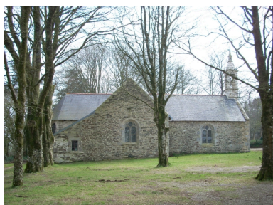
Briec, chapelle Notre-Dame d'Illijour : élévation nord Phot. Gwénaél Fauchille IVR53_20082905492NUCA
