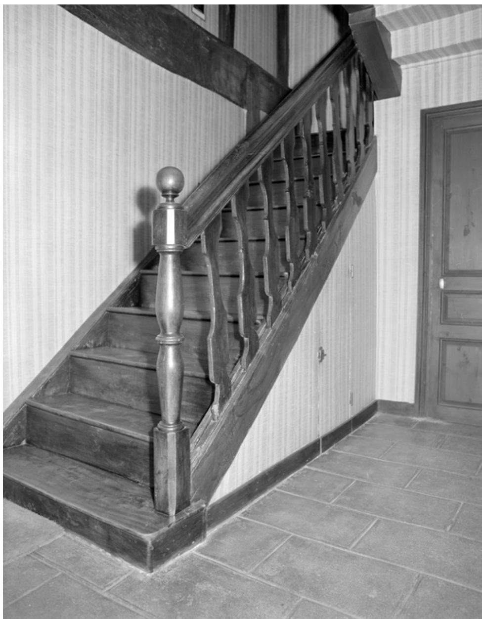
Escalier : rampe et balustres
