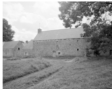
Façade postérieure Phot. Guy Artur IVR53_19752200230X
