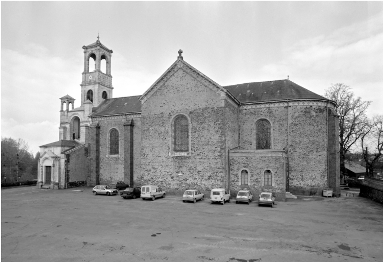
Elévation ouest : vue générale
