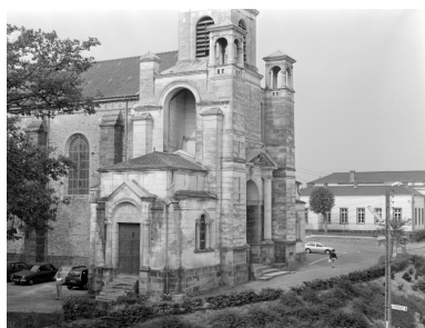
Vue nord-ouest de l'église Phot. Guy Artur, Phot. Norbert Lambart IVR53_19893500139X
