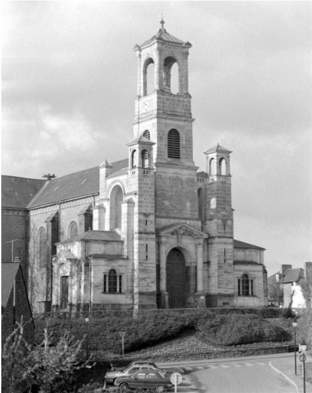
Elévation nord : vue générale
