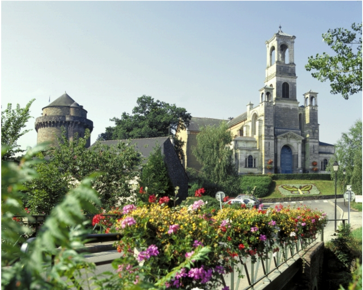
Vue nord de l'église
