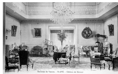
Vue intérieure : le hall Phot. Elise Lauranceau IVR53_20045606222NUCB
