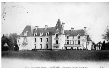
Vue générale de la façade sud Phot. Elise Lauranceau IVR53_20045606223NUCB
