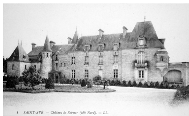
Vue générale Phot. Elise Lauranceau IVR53_20045606224NUCB
