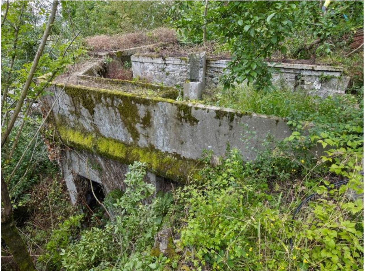
Vue de la serre située au Sud : elle comprenait deux niveaux (serre vitrée en rez-de-chaussée avec bacs de culture et local technique à usage de chaufferie au sous-sol)
