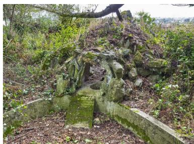
Vue de la grotte artificielle (faisant abri pour un ou des animaux) du bassin : élévation Nord percée d'un porte et rampe d'accès. Sa couverture est ornée de coquilles Saint-Jacques en ciment et de rocaille
