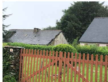
Vestiges de l'atelier de tissage. Vue sud prise depuis la rue. Etat en 2018 Phot. Véronique Bardel IVR53_20262910107NUCA
