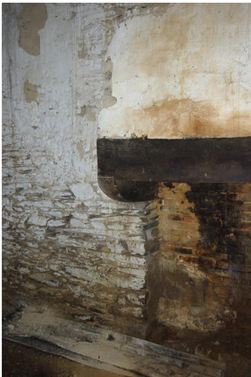
Vestiges de l'atelier de tissage. Détail d'une cheminée. Etat en 2018
