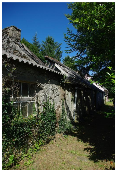
Vestiges de l'atelier de tissage. Etat en 2018 Phot. Véronique Bardel IVR53_20262910108NUCA
