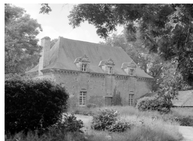
Ferme datée 1647, élévation sud. Phot. Norbert Lambart IVR53_19815600462X
