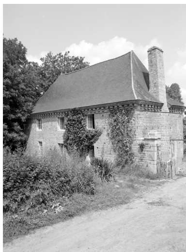
Ferme datée 1647, élévation sud. Phot. Norbert Lambart IVR53_19815600461X
