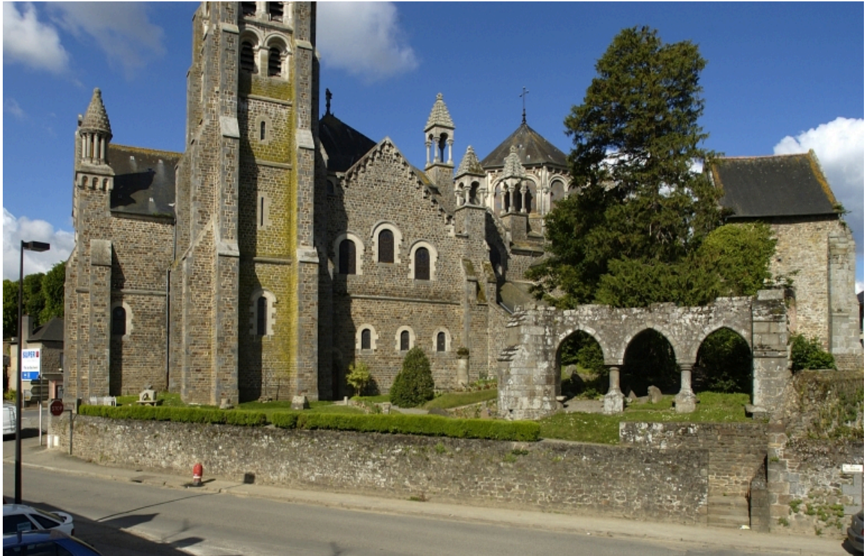
Elévation nord-est et vestiges de l'ancienne église
