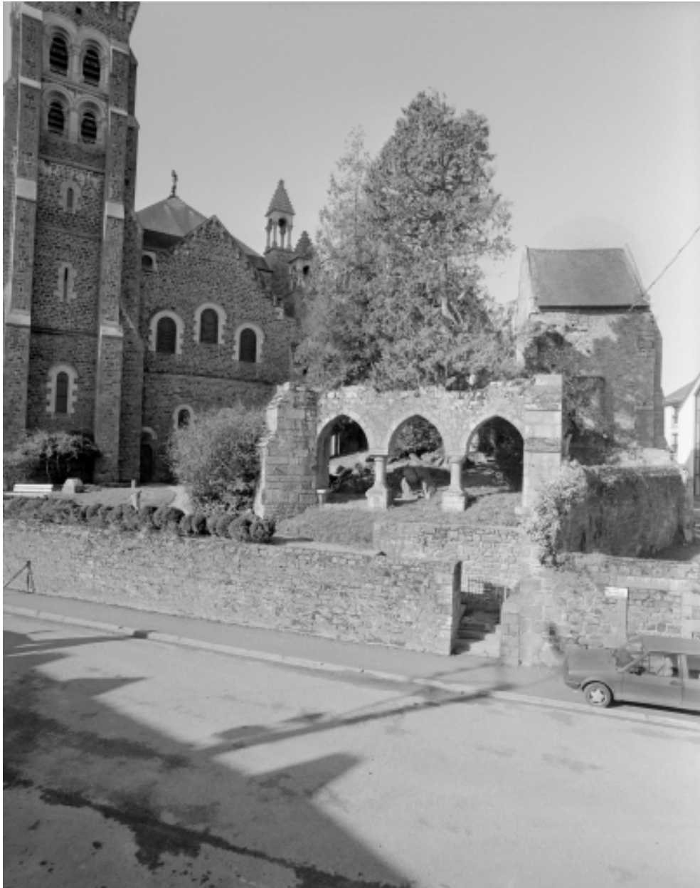
Elévation nord-est et vestiges de l'ancienne église
