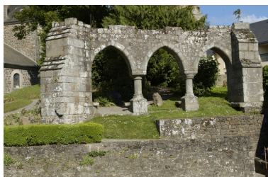
Vestiges de l'ancienne église, ensemble de trois arcades Phot. Norbert Lambart IVR53_20063501195NUCA
