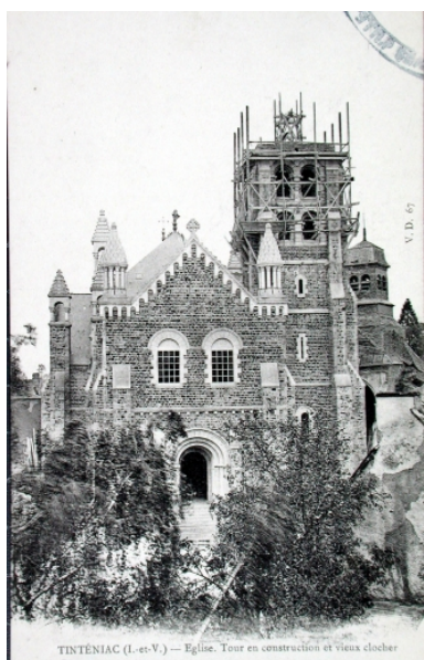
Construction de l'église paroissiale Phot. Elise Lauranceau IVR53_20063512072NUCB
