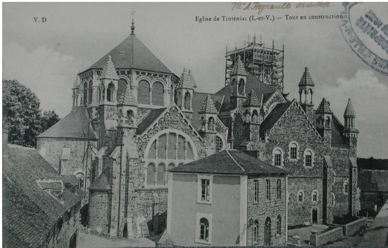
Construction du clocher
