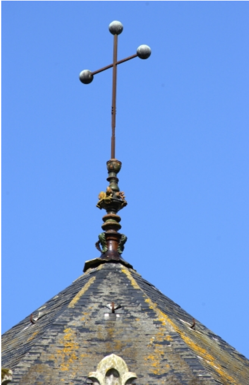
Détail du couronnement de la toiture centrale
