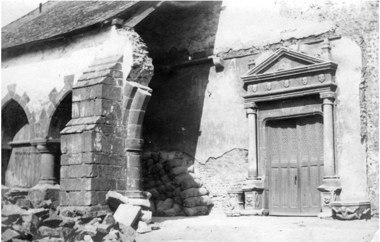
Vue de l'ancienne église paroissiale lors de sa démolition
