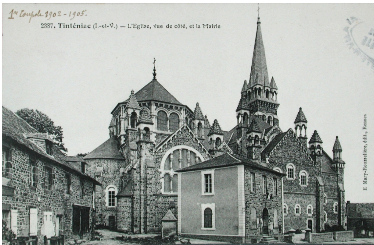
Vue générale au début du 20e siècle
