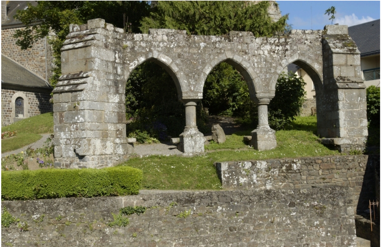
Vestiges de l'ancienne église, ensemble de trois arcades
