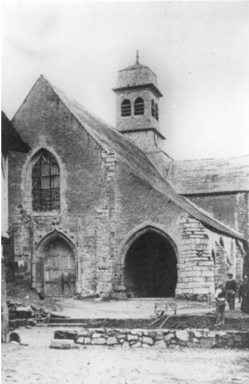
Vue générale ouest de l'ancienne église paroissiale
