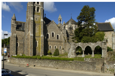
Elévation nord-est et vestiges de l'ancienne église Phot. Norbert Lambart IVR53_20063501197NUCA
