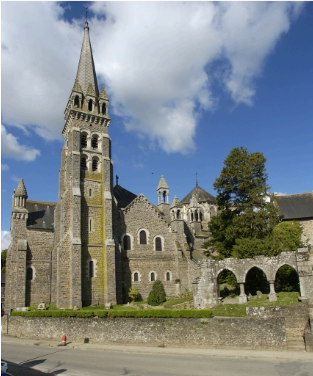
Elévation nord-est et vestiges de l'ancienne église
