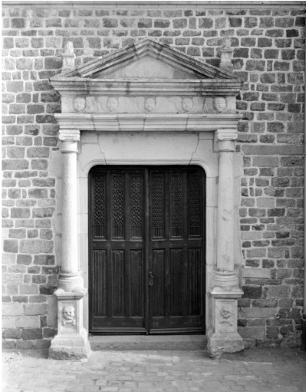
Elévation sud, porte : vue générale.
