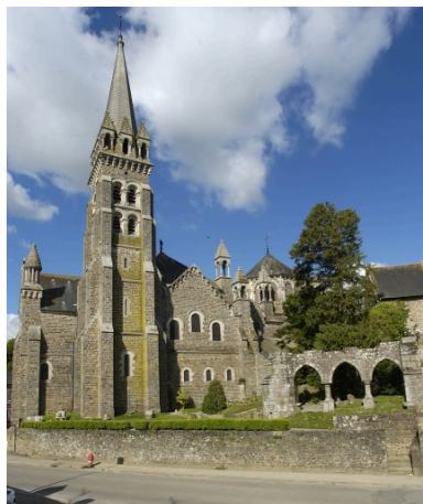
Elévation nord-est et vestiges de l'ancienne église Phot. Norbert Lambart IVR53_20063501196NUCA
