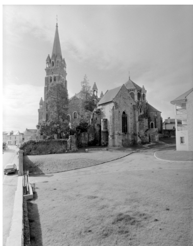
Elévation nord : vue générale Phot. Guy Artur, Phot. Norbert Lambart IVR53_19953500073X
