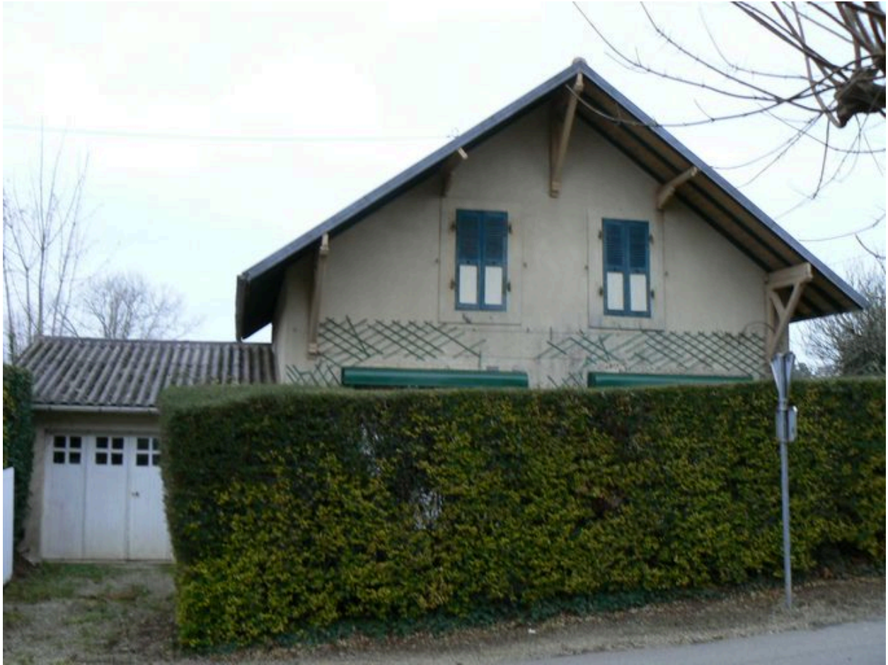
Vue générale de la villa Malakoff
