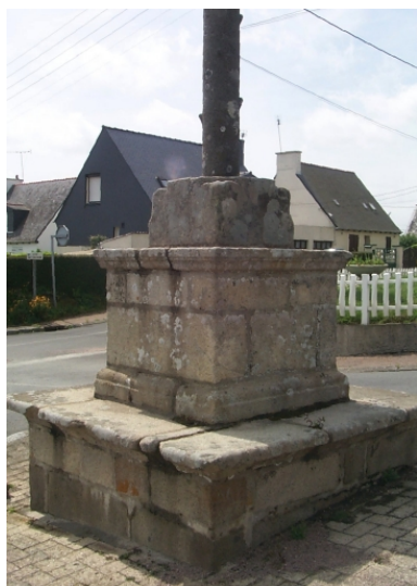
Socle et soubassement Phot. Patrick Pichouron IVR53_20072209590NUCA
