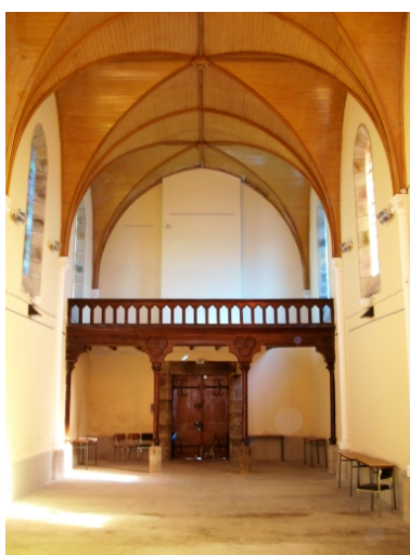
Lesneven, chapelle Saint-Maudez : vue axiale ouest Phot. Gwénaél Fauchille IVR53_20082906348NUCA
