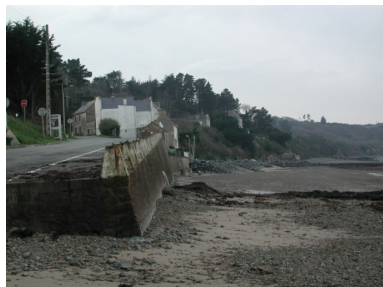
Vue générale du quai ou cale de débarquement de Port Lazo construite en 1941 Phot. Guy Prigent IVR53_20022215793NUCA
