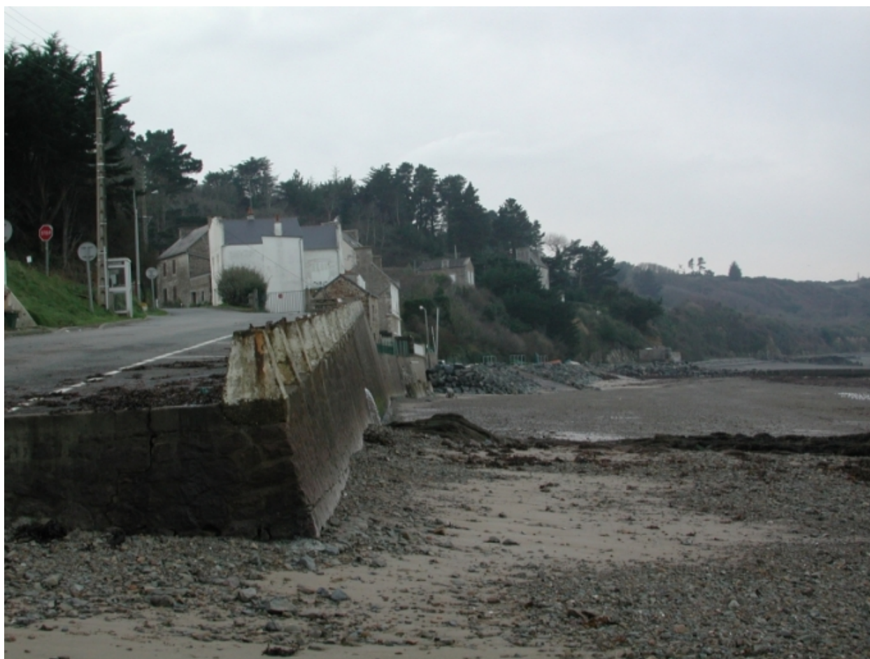
Vue générale du quai ou cale de débarquement de Port Lazo construite en 1941
