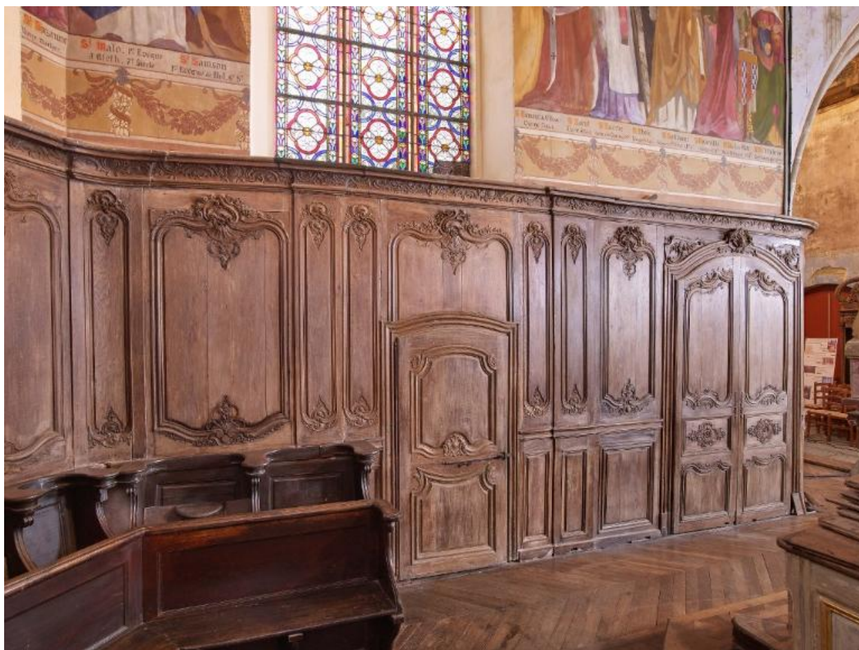
Lambris de revêtement, sud du chœur
