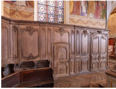
Lambris de revêtement, sud du chœur Phot. Bernard Bègne IVR53_20202200723NUCA
