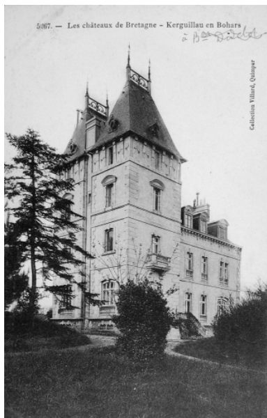
Vue générale Phot. Elise Lauranceau IVR53_20042905505NUCB
