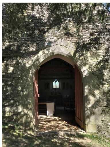
Porte principale Phot. Michèle Bureau IVR53_20255610304NUCA
