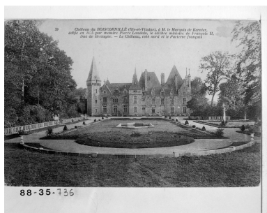
Façade nord et jardin : vue générale Phot. Guy Artur, Phot. Norbert Lambart IVR53_19883500736X
