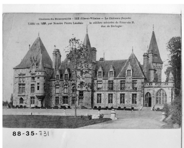
Façade sud : vue générale Phot. Guy Artur, Phot. Norbert Lambart IVR53_19883500731X
