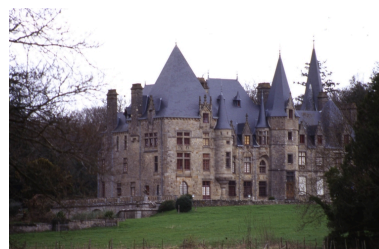
Vue générale de l'élévation sud du château Phot. Guy Artur, Phot. Norbert Lambart IVR53_19943503116ZA
